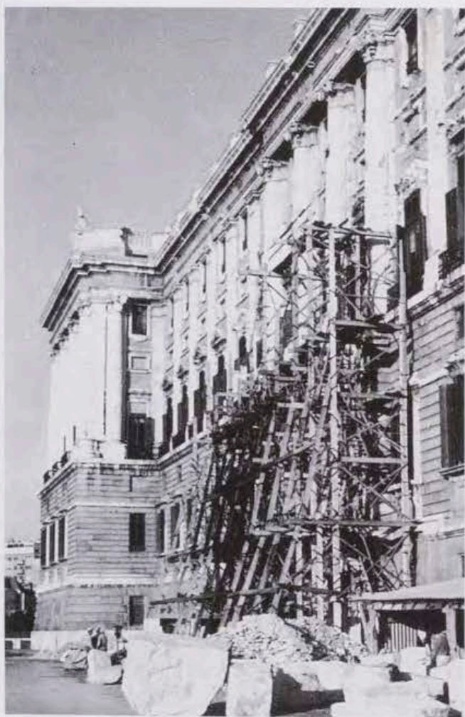
Fig. 1 Obras de reparación en la fachada de poniente del Palacio Real de Madrid después de la Guerra Civil con los bloques de piedra que se labraban a pie de obra.
