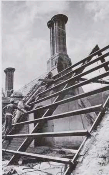
Figs. 19 y 20 Obras de reconstrucción de las cubiertas del Real Monasterio de San Lorenzo de El Escorial, 1965-1969.
