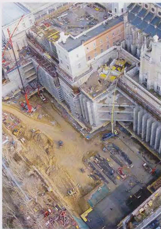
Figs. 22 y 23 Obras de construcción del Museo de Colecciones Reales en 2007-2008. Arquitectos Luis Moreno García-Mansilla y Emilio Tuñón Álvarez.
