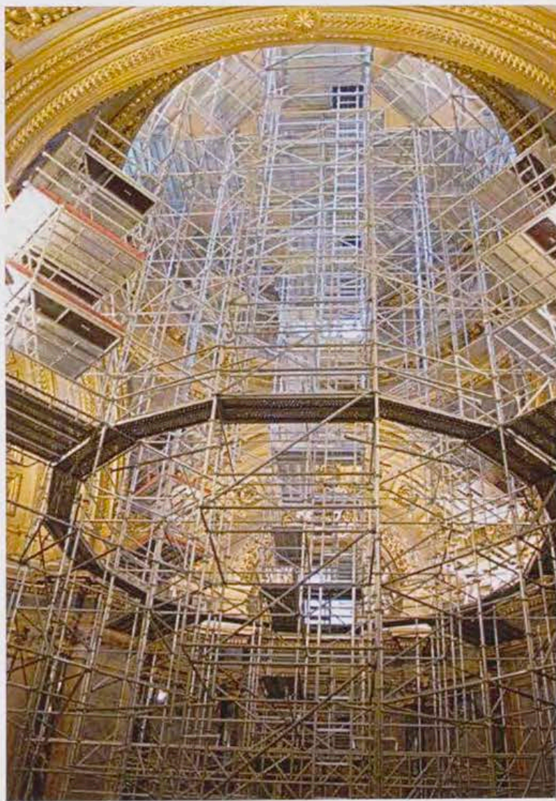
Fig. 11 Andamiaje instalado en la Capilla Real para la restauración de la cúpula en 2008-2011, Palacio Real de Madrid.
