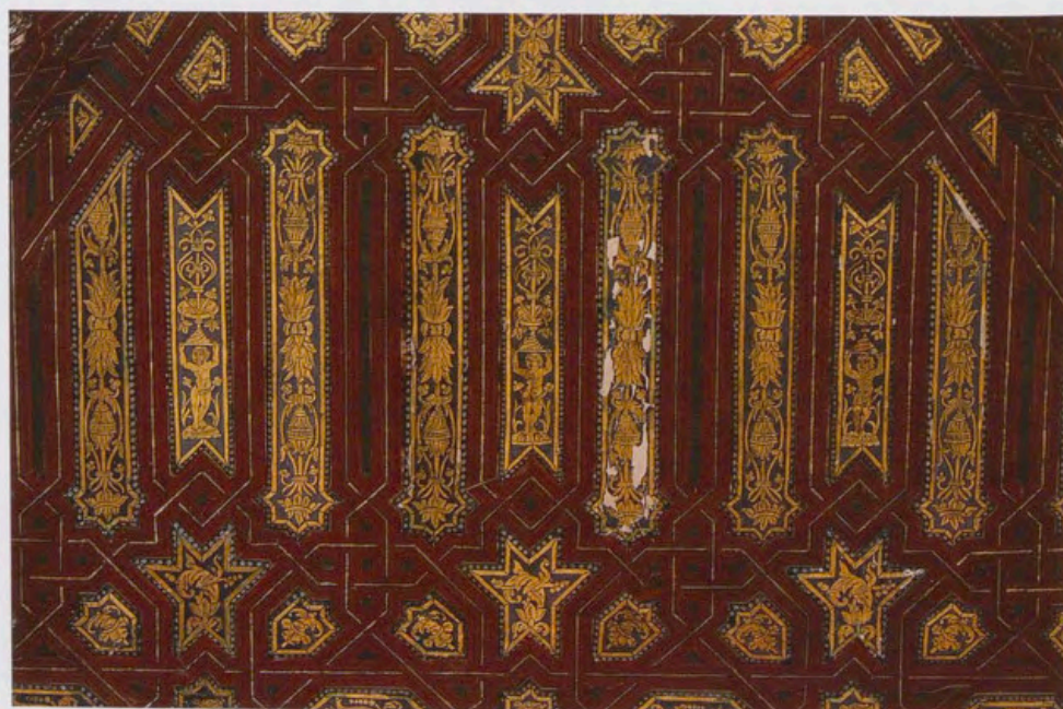
Fig. B. Armadura de madera dorada y policromada «al romano» en el Salón Dorado del Palacio de la Alhambra.
