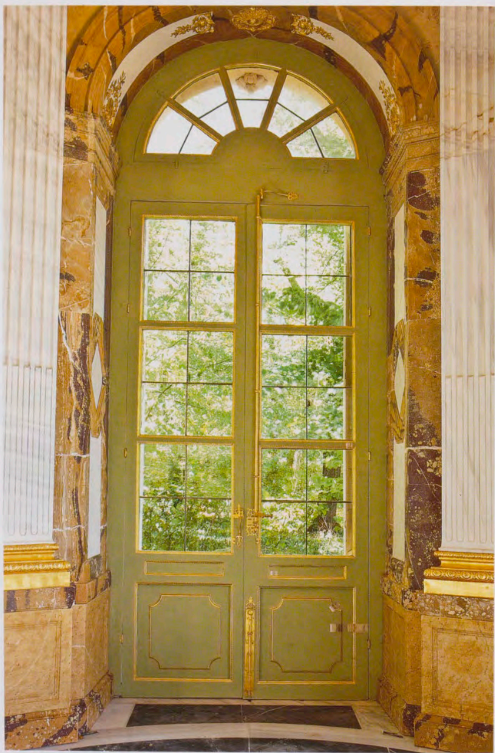
Fig. 14. Una de las puertas vidrieras. El color verde original (de 1733) ha sido recuperado en la restauración; en la cata realizada en la parte inferior derecha se aprecia la estratificación de las intervenciones posteriores.
