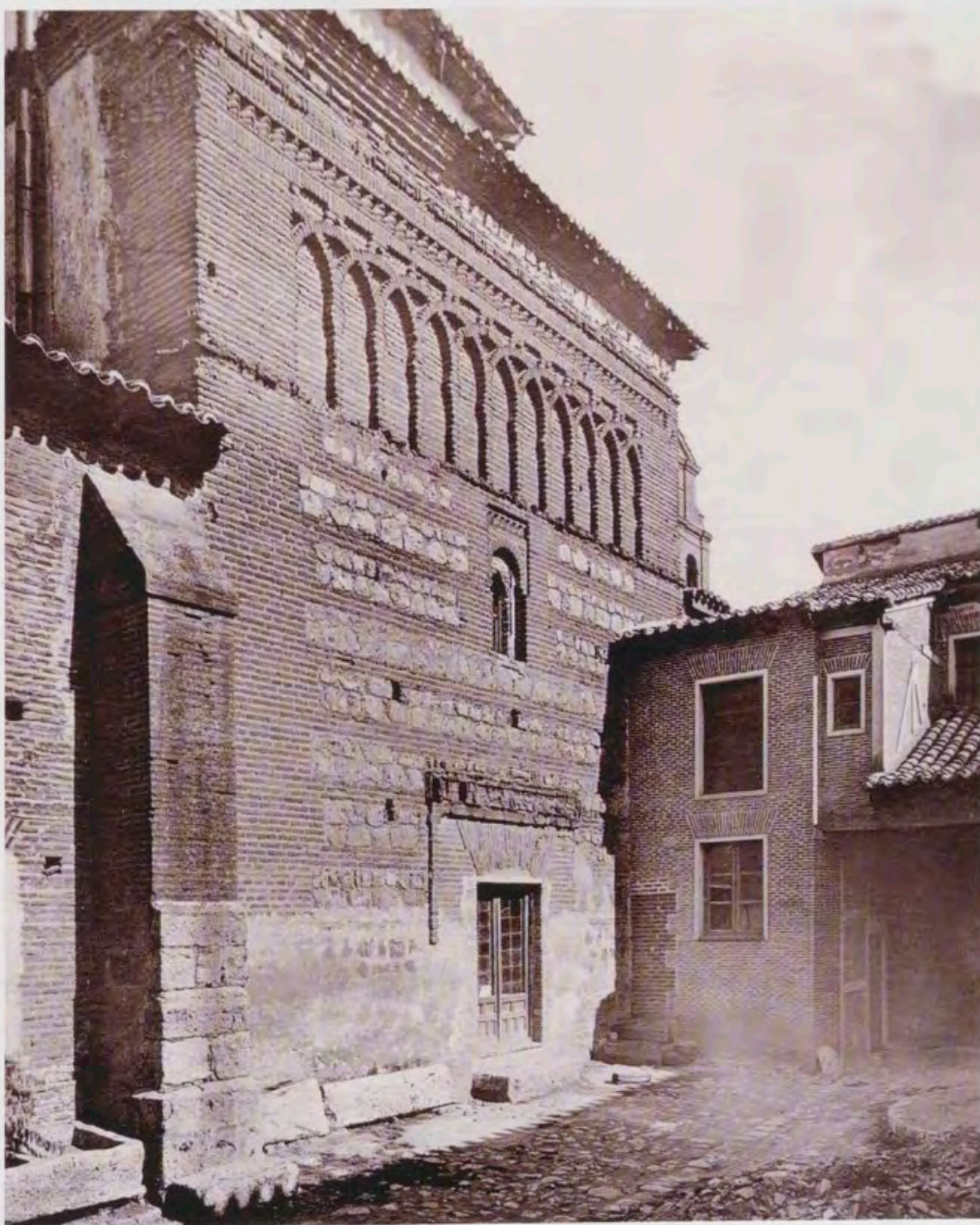
Fotografía antigua del exterior de la Capilla Dorada. A la izquierda de la entrada se ve un contrafuerte de piedra, hoy desaparecido.
