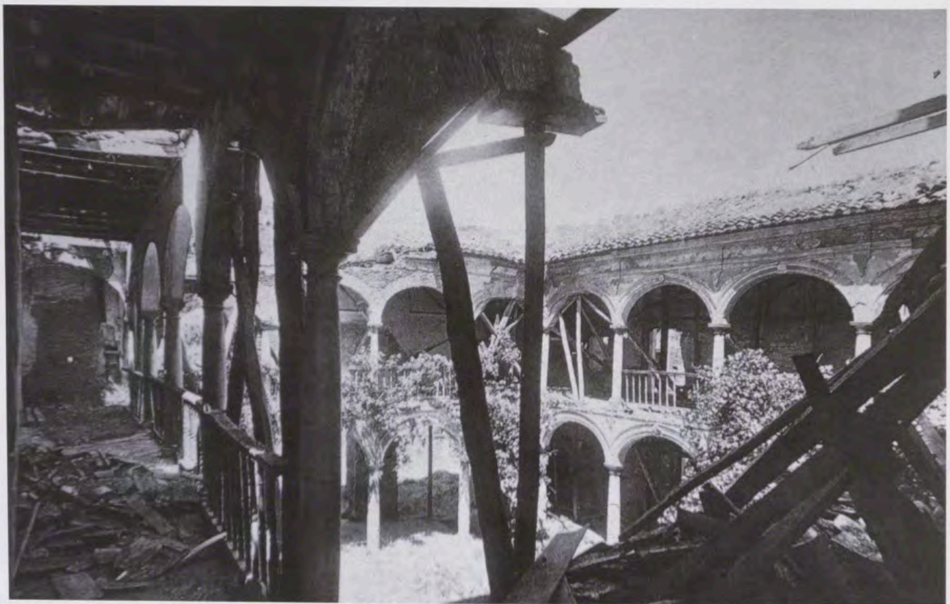
El Patio del Convento de San Francisco de la Alhambra con las galerías hundidas, fotografía de Torres Molina, 1924, Archivo y Museo Casa de los Tiros, Consejería de Cultura de la Junta de Andalucía, Granada.
