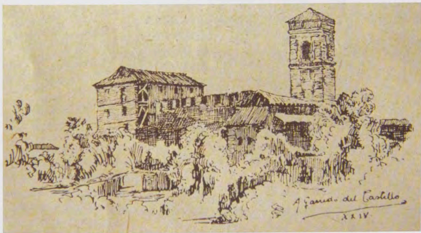
Convento de San Francisco de la Alhambra en ruinas, dibujo de Garrido del Castillo, en la obra Granada gráfica, publicado en julio de 1924, Archivo y Museo Casa de los Tiros, Consejería de Cultura de la Junta de Andalucía, Granada.
