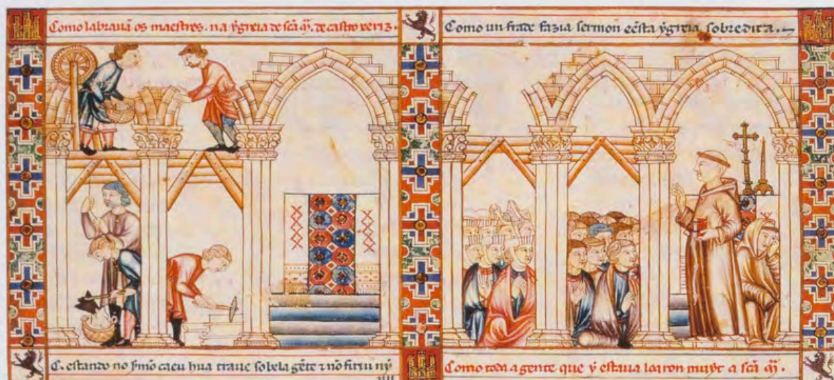
Construcción de una iglesia, detalle del folio 84r, Códice de Florencia, Ms., B.R. 20, Ministero per i Beni e le Attività Culturali, Biblioteca Nazionale Centrale, Florencia, Fotografía: MicroFoto.
