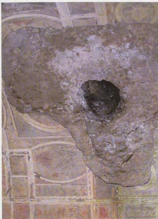
Sala della Volta Dorata, Domus Aurea, Roma. Fotografía: Fernando Marías.
