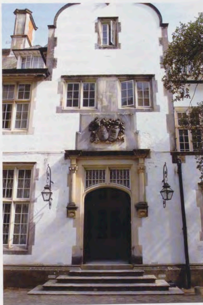
Entrada principal de Guadacorte, Fotografía: Doro.
