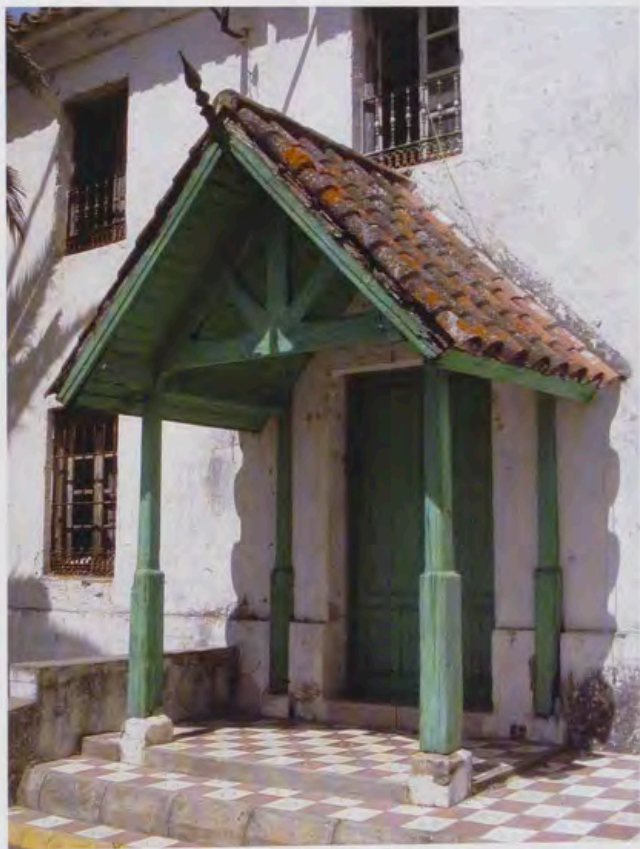
Porche de la Casita de Campo de San Martín del Tesorillo, Entidad Local Autónoma de San Martín del Tesorillo, Cádiz.
