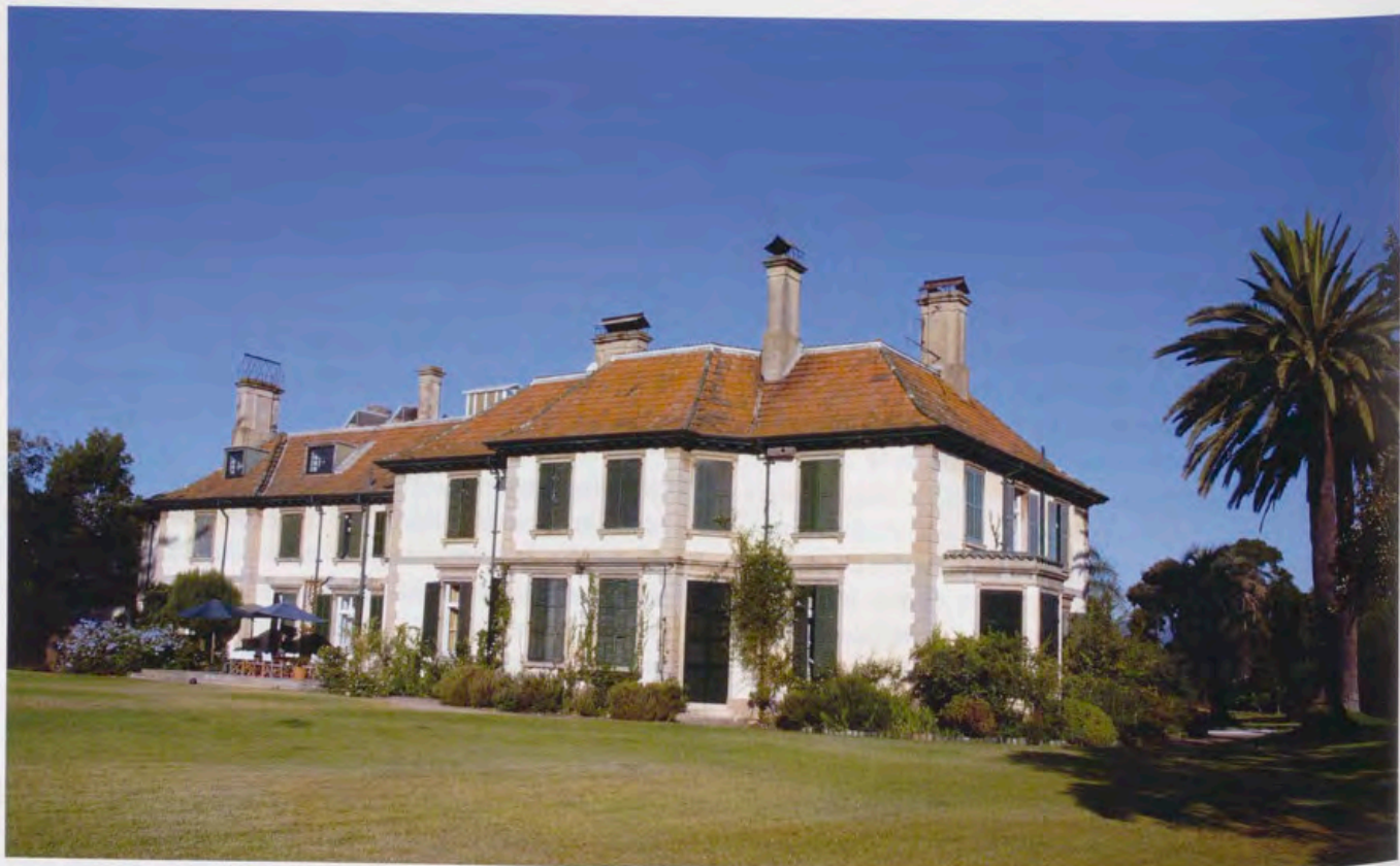
Fachada al Jardín de Monte de la torre, Los Barrios, Cádiz. Fotografía: Doro.
