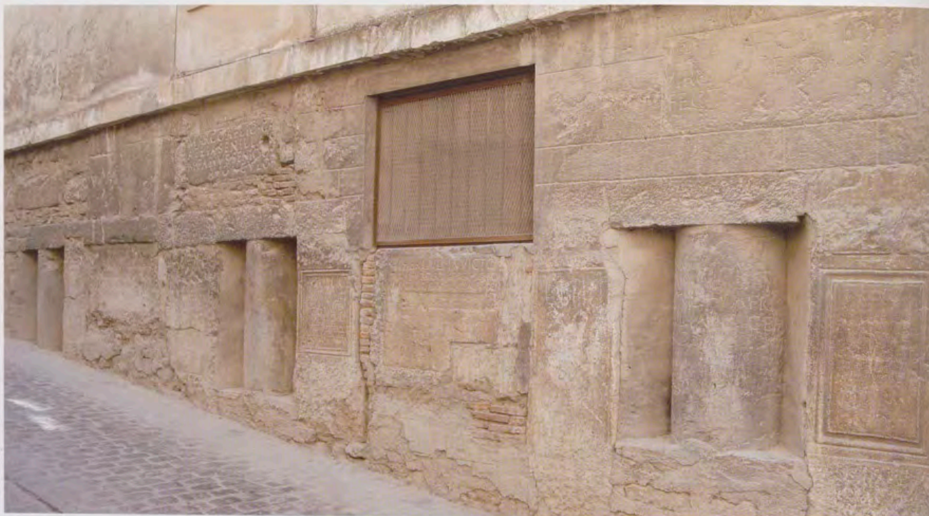
Fachada lateral con restos arqueológicos y detalles de los mismos, de la Cárcel y Cabildo de Martos (Jaén), Concejalía de Cultura, Patrimonio Histórico, Fotografía: Jesús de la Torre (Hobby Color).
