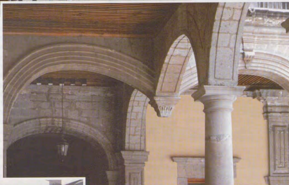
Palacio de la Inquisición (1733-1737) de Pedro Arrieta. Arcos cruzados y pendientes en el aire de una de las esquinas del patio, México. Fotografía: J. Bérchez.
