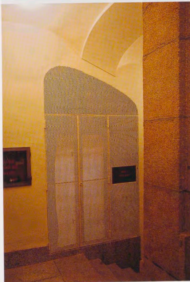
Recuperación efectuada en la escalera lateral.
