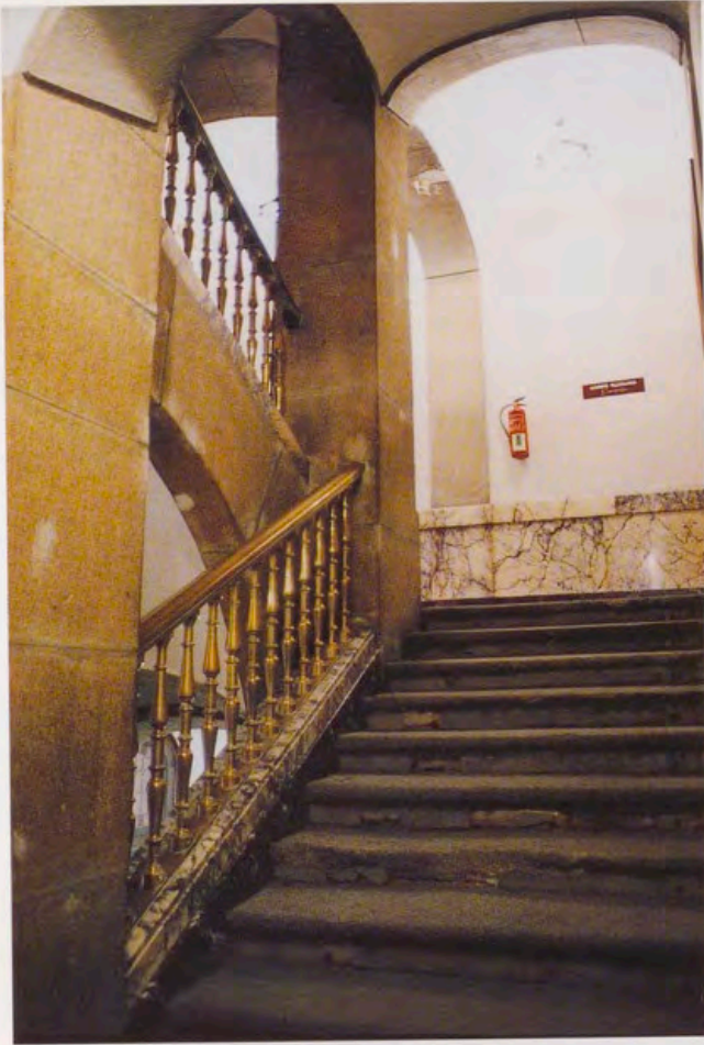
Escalera lateral antes de la restauración.
