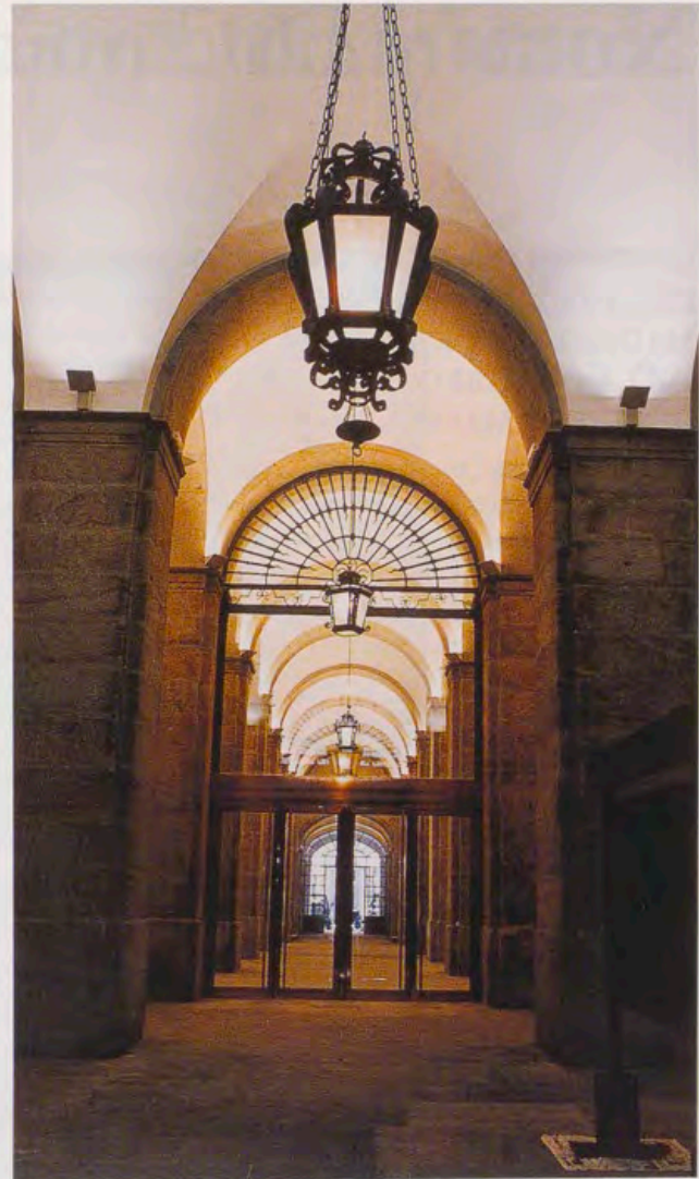
Recuperación del eje de tránsito de conexión entre la calle de Alcalá y el patio del fondo.
