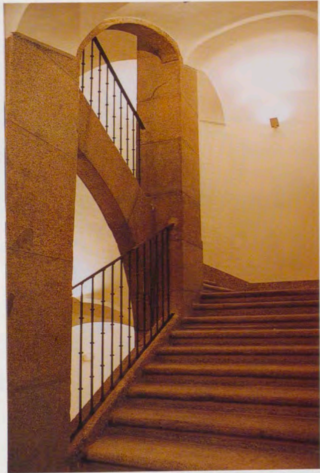
Escalera lateral después de la restauración.
