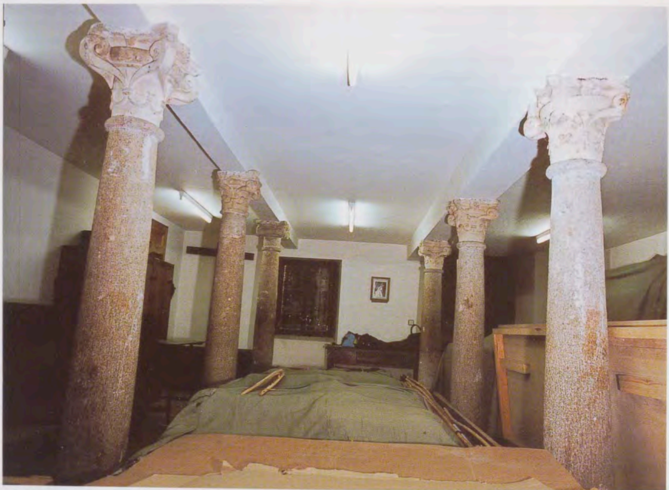
Sala de columnas en la planta baja.
