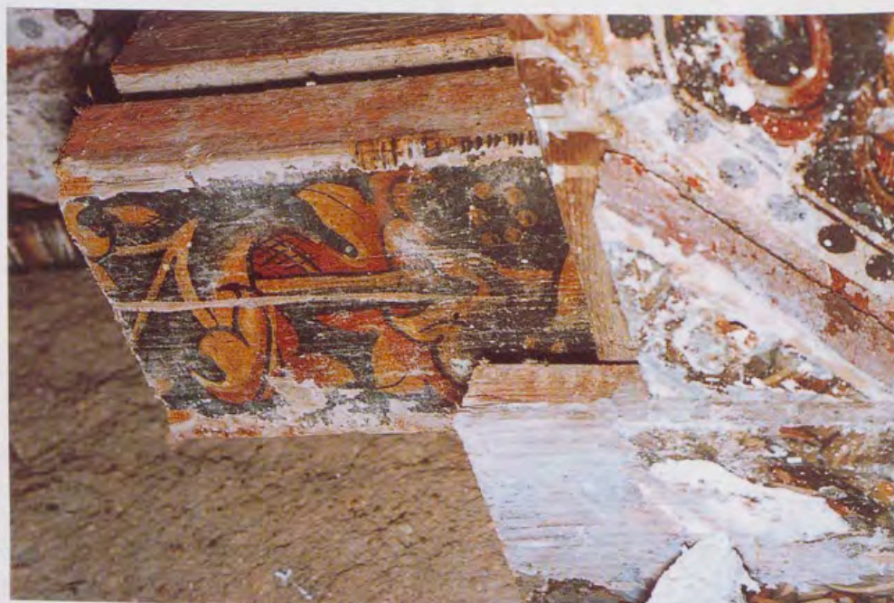
Detalle de una viga policromada aprovechada en la estructura del techo de la Capilla de San José.
