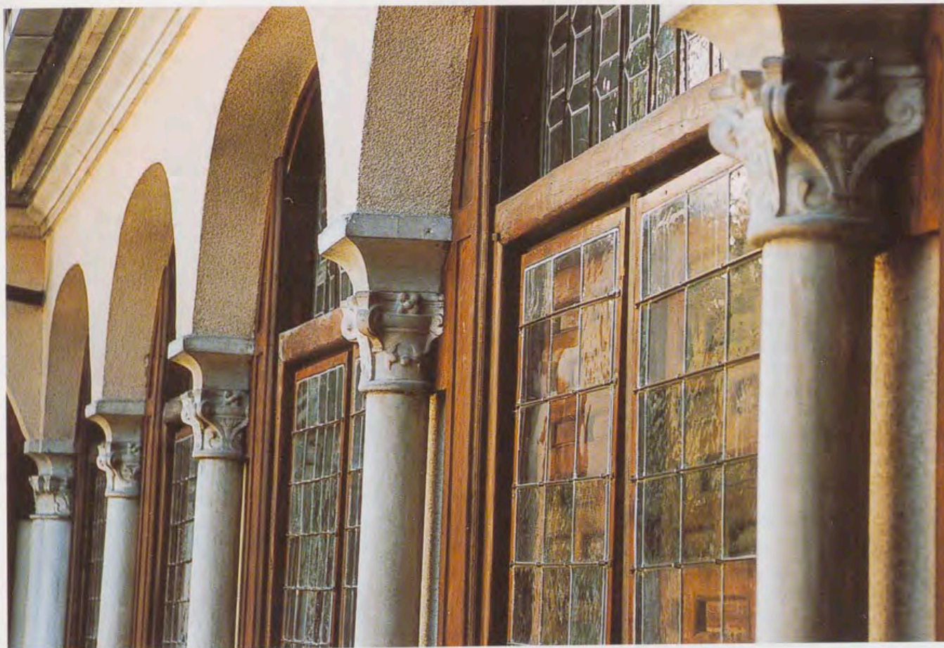
Patio principal. Detalle de columnas y capiteles del piso alto.
