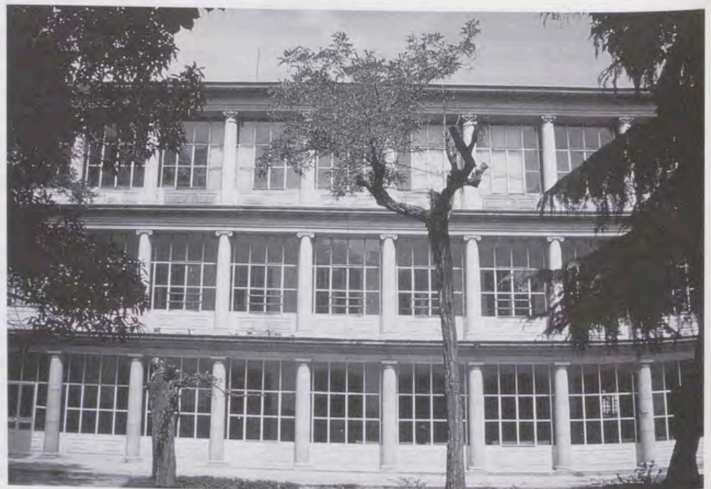
Fachada principal del Palacio Viejo, con acristalamiento posterior.
