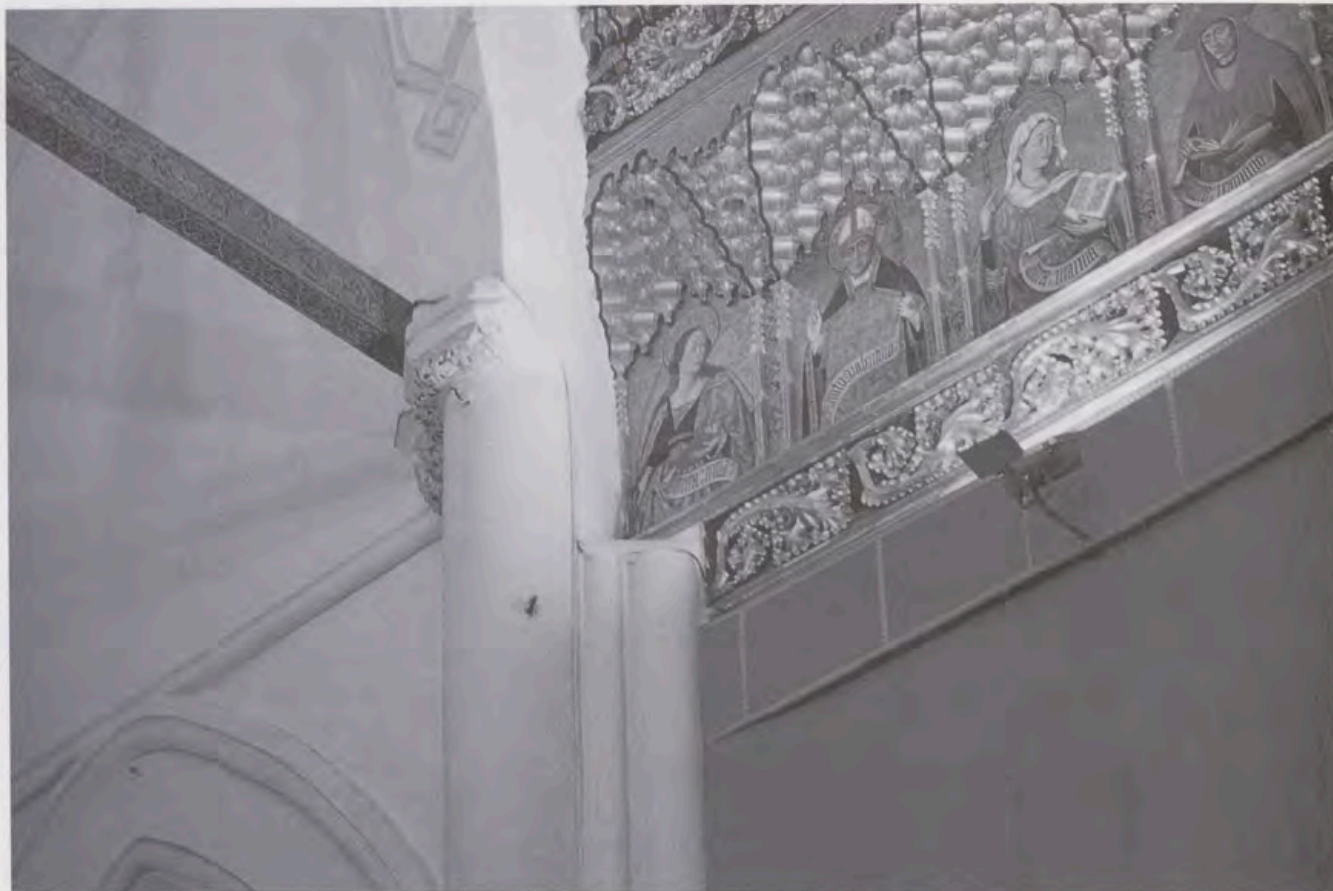
Unión de la techumbre de la Iglesia con el resto del cuerpo del Templo. Baquetones realizados para recibir los nervios de las bóvedas de crucería proyectadas.
