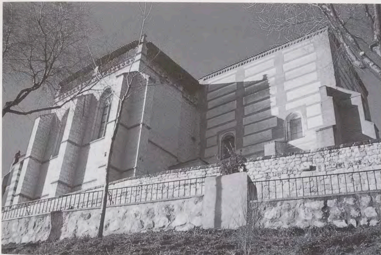
Cabecera de la Iglesia y Capilla del Contador Saldaña.
