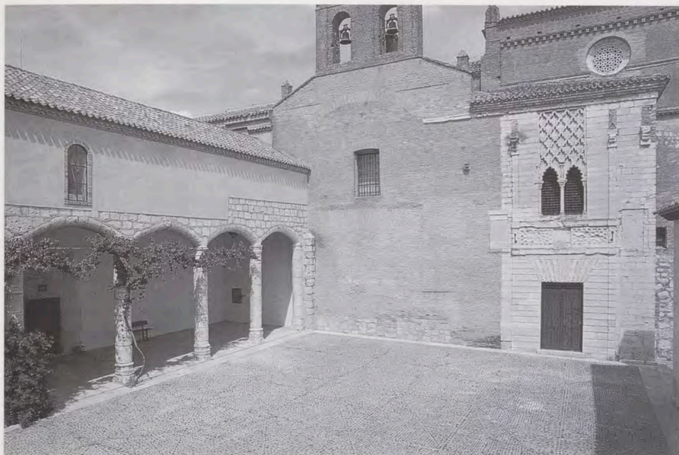
Fachada conservada del Palacio.
