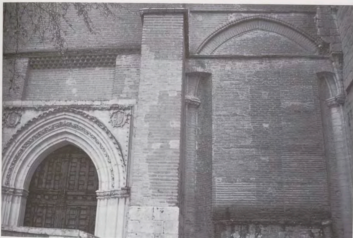
Pórtico de la Iglesia desmontado junto a la Capilla de los Saldaña. Restos del arranque de las nervaduras y portada trasladada perteneciente a dicho pórtico.
