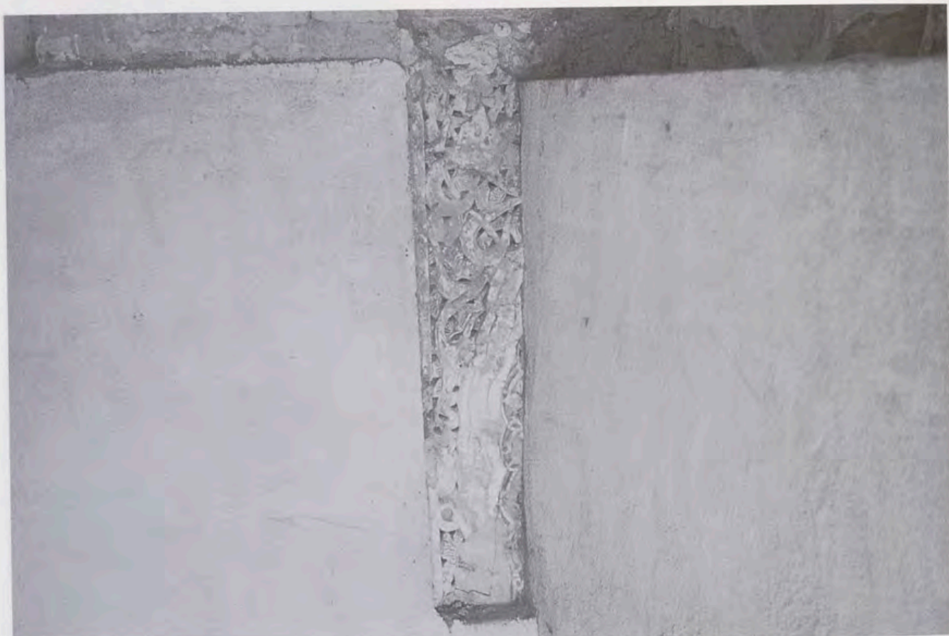
Restos de la ventana conservada en el lado norte del piso superior del vestíbulo. Siglo XIV.
