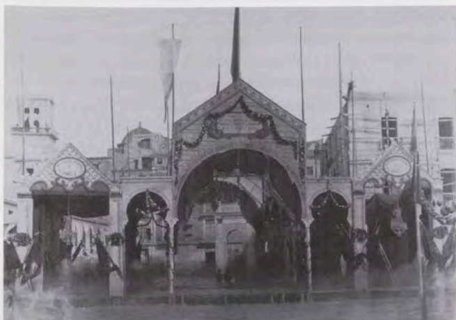
Charles Clifford. Alicante. Estación improvisada a la entrada del Muelle. 1860.
