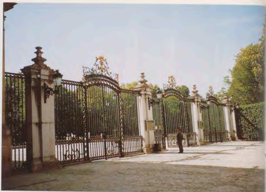
Gran Puerta-reja de entrada a los jardines desde la población de San Ildefonso. Intervención del cerrajero Fernando Garrido, c. 1742-1743, sobre obras de Sebastián de Flores.
