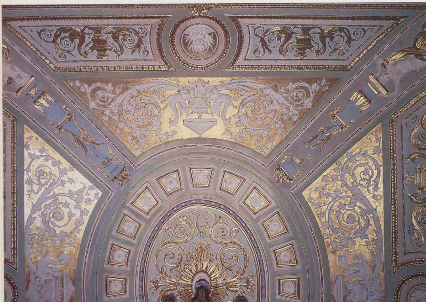
Detalle del techo.
