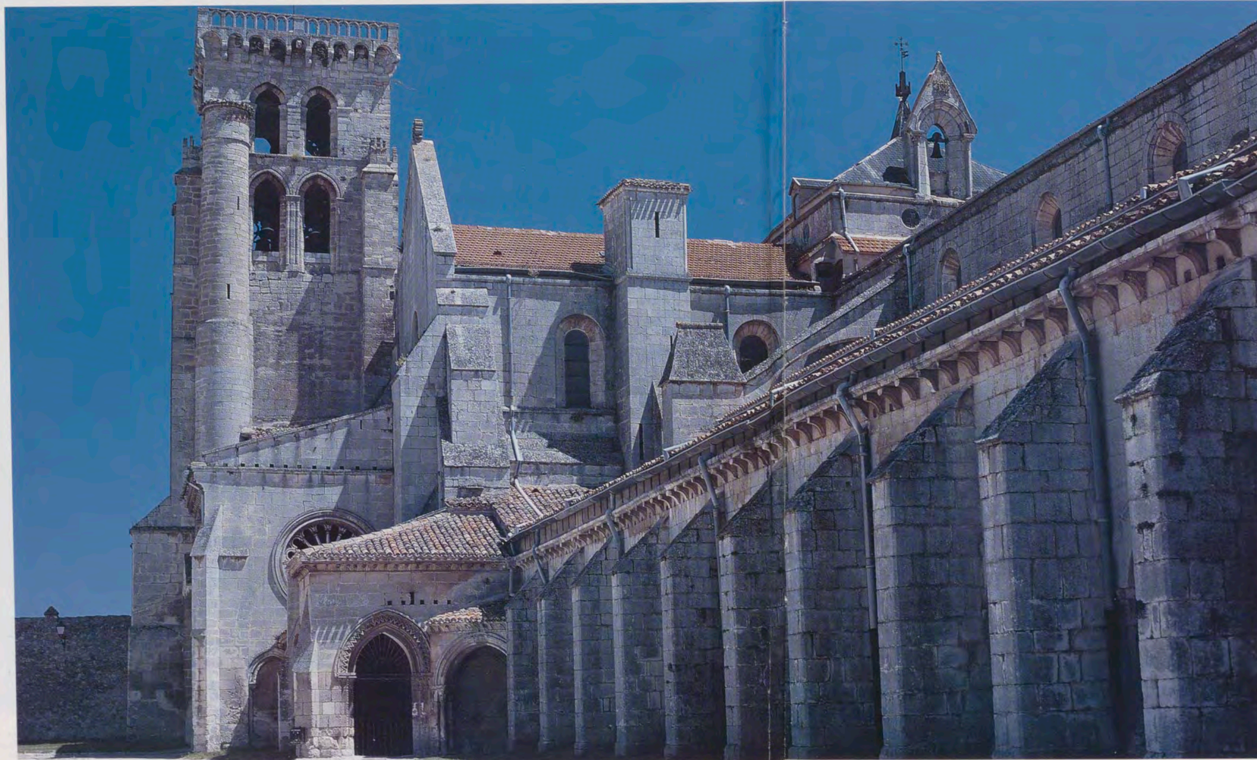
Vista exterior del Monasterio de Las Huelgas.
