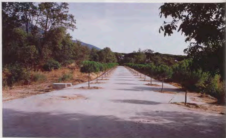
Camino de la Casita del Príncipe en el Parque de ésta, una vez estabilizado y recuperado.
