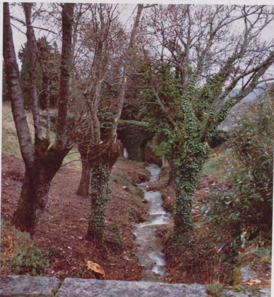
Recuperación de márgenes del Arroyo del Infante en el Parque de la Casita de Arriba.
