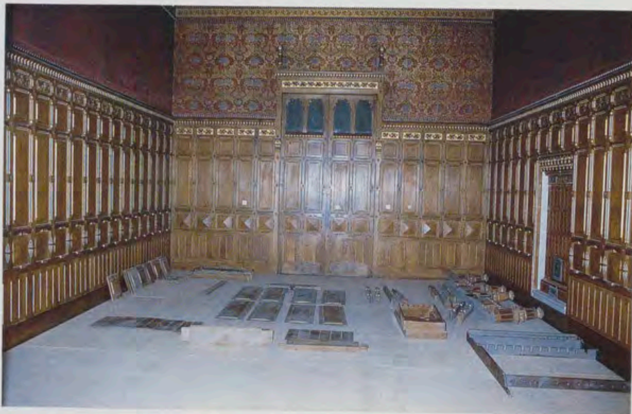
Vista general de la Sala de Billar durante el proceso de restauración.
