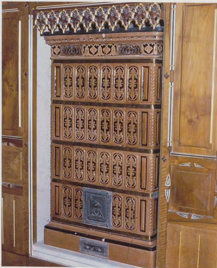
Estufa instalada en la pared.
