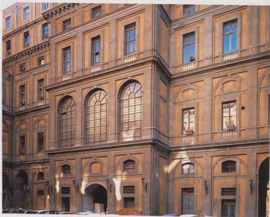
Patio interior de la Real Casa de la Aduana.
