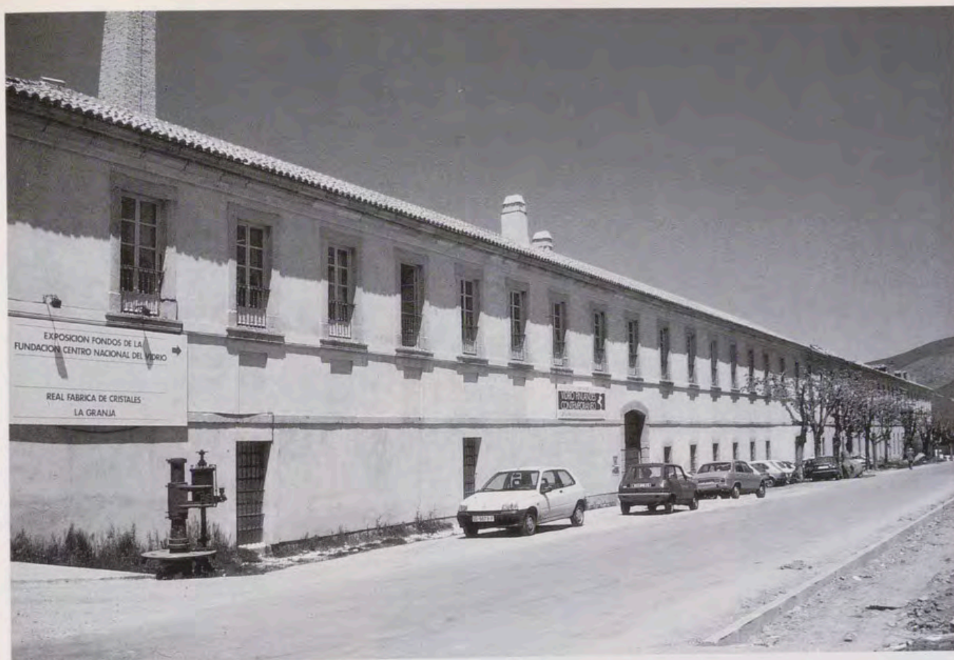
Fachada Este de la Fábrica de Planos, extramuros del Real Sitio.
