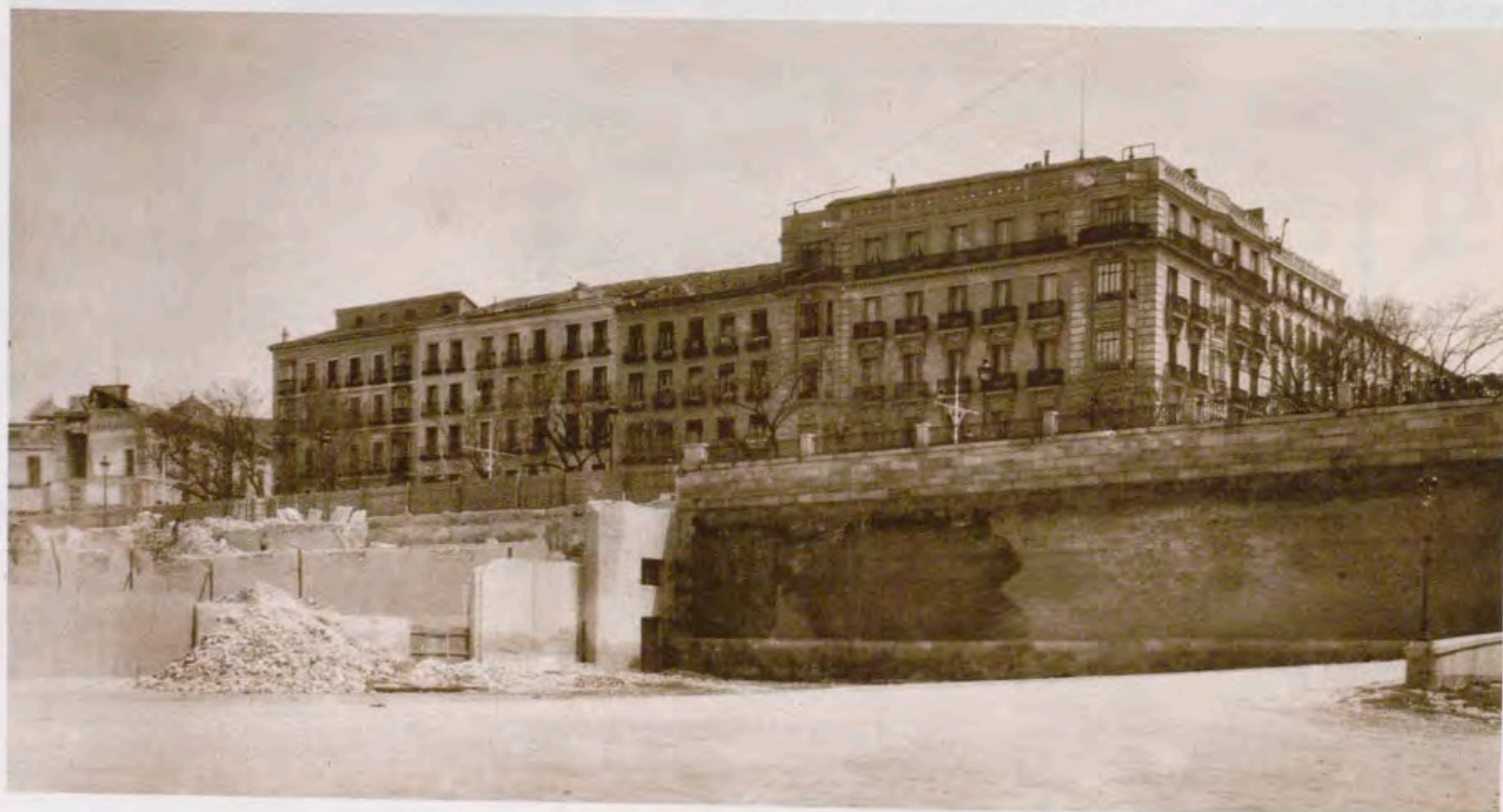
Estado del derribo (muro de contención de la calle de Bailén) en abril de 1934.
