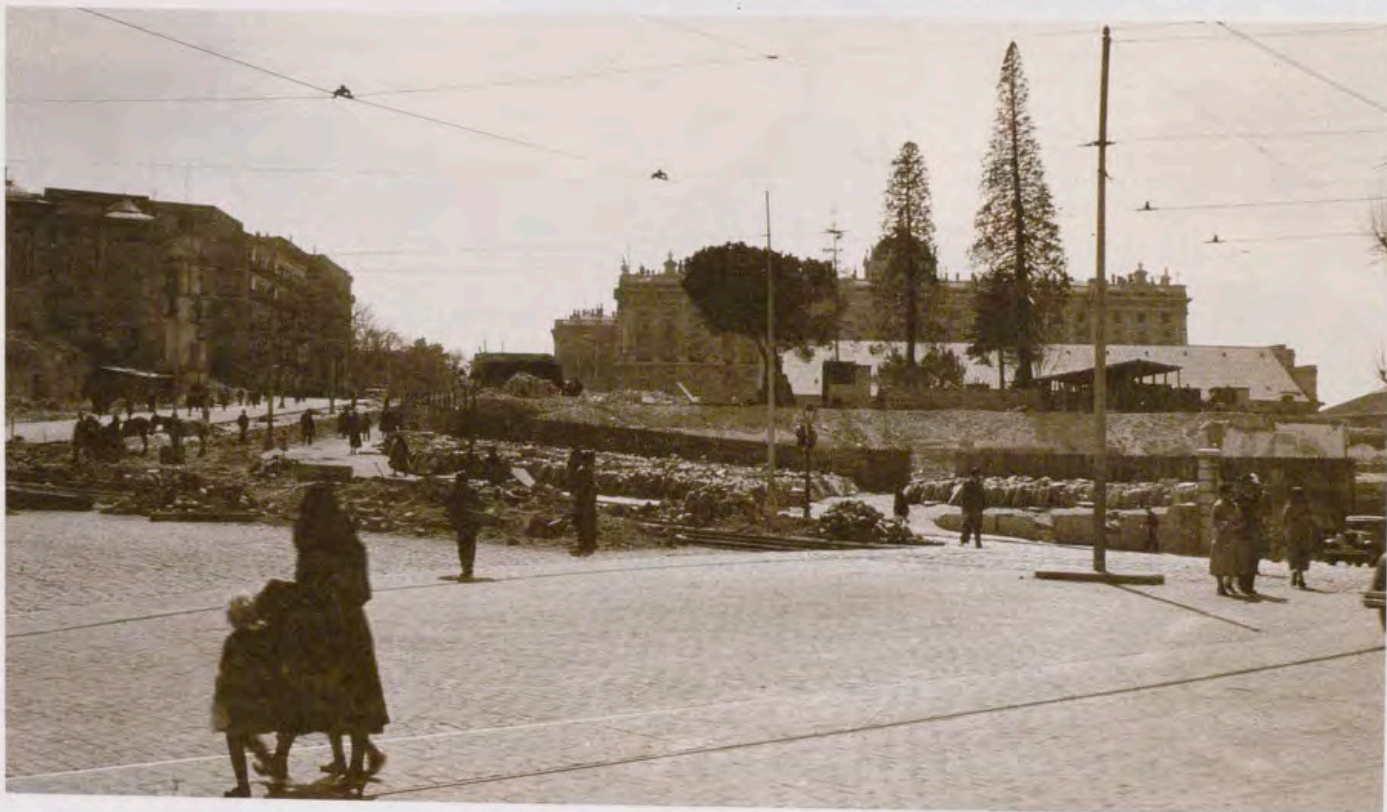
Estado del derribo en abril de 1934. El futuro chaflán de ingreso principal. (Fragmento de la Memoria-1934. En Arquitectura 1935).
