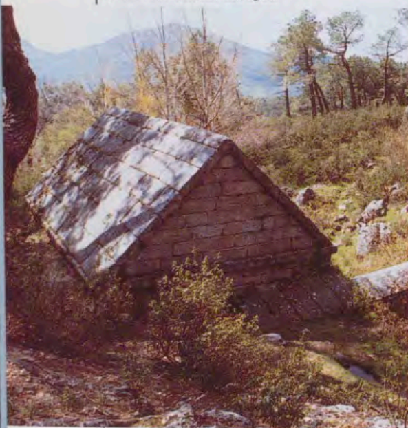
Arca del Helechar y canal de entrada del agua.
