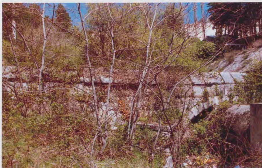
Detalle del canal de entrada de agua del Arca del Romeral.
