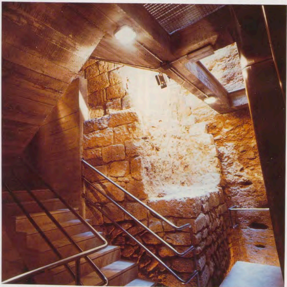
Aparejo ordenado en el arranque de la muralla.
