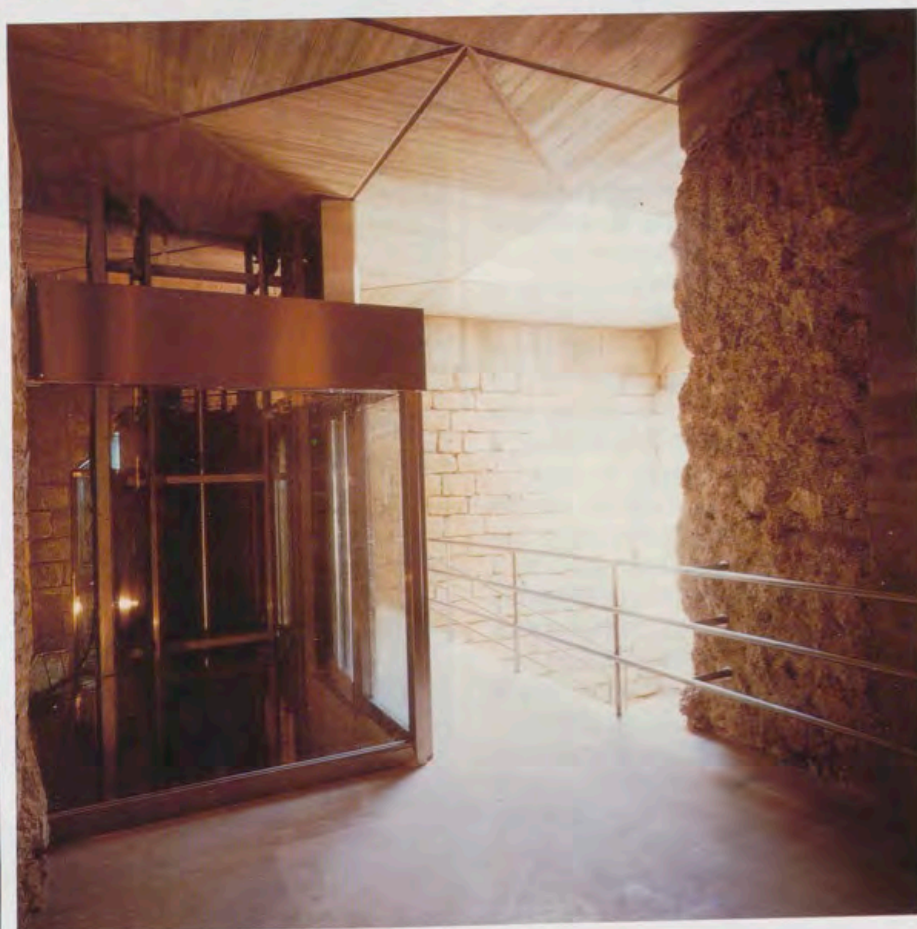
Vista a media altura en el interior del nuevo acceso.
