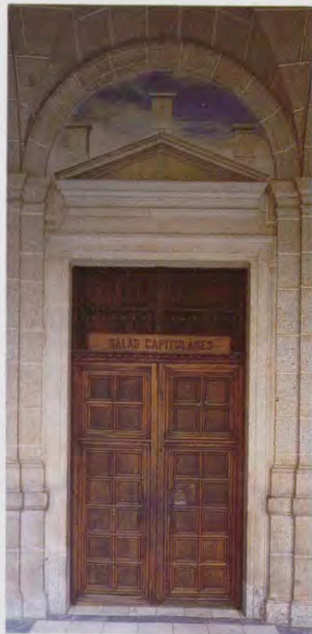
Entrada exterior a los Capítulos por el Claustro Principal.
