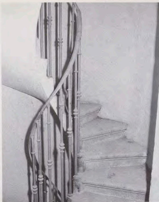
Escalera de caracol. A ambos lados del Salón del Trono, y aprovechando el grosor de las paredes, existen dos escaleras que comunican el piso de Damas con el Cuarto Público del Rey.
