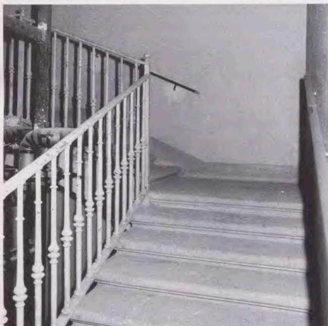
Escalera de Servicio. La escalera arranca en el piso bajo y llega hasta el de Damas.
