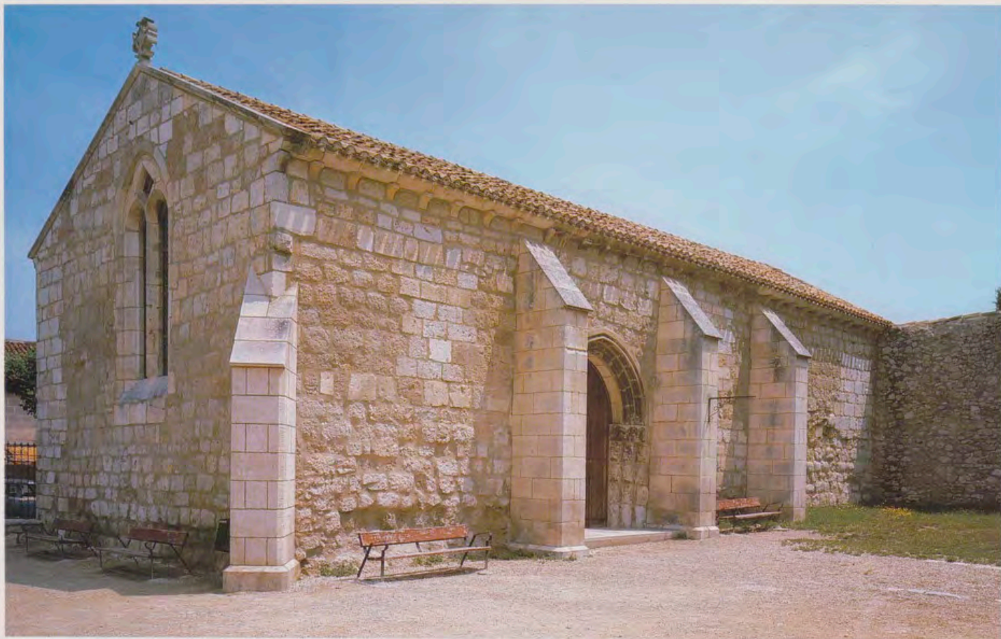
Exterior de la Capilla de San Martín, que cierra el conjunto monástico burgalés por su linde norte.
