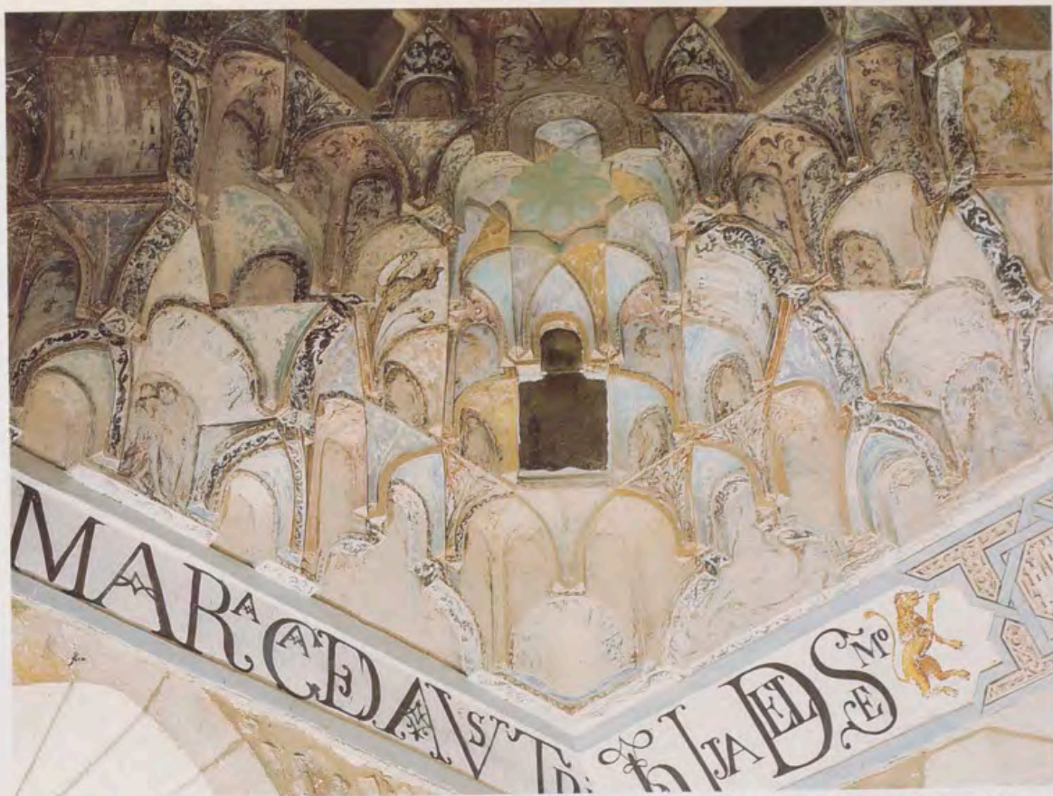
Mocárabes de yeso pertenecientes a la cúpula de la Capilla del Salvador, semejantes a los de las mezquitas marroquíes de Abd al-Mumin.
