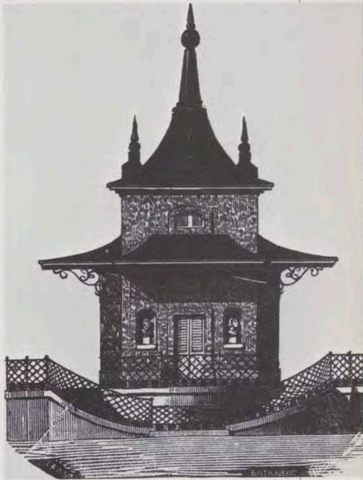
Casa del Pescador del Buen Retiro («La Ilustración», 15 de septiembre de 1849).
