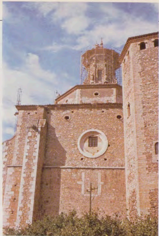
Fachada de Levante de la Sacristía, con la torre de las Hostias en primer término.
