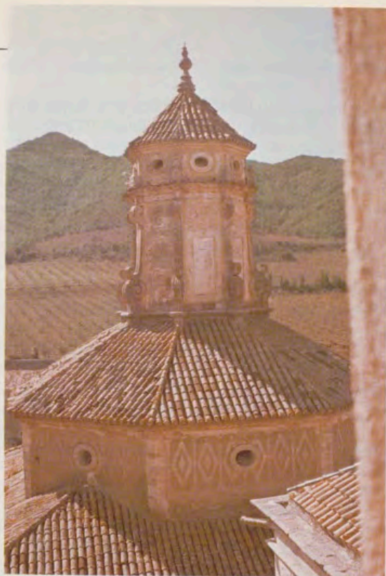
Tambor de la cúpula y linterna, antes de la apertura de huecos.
