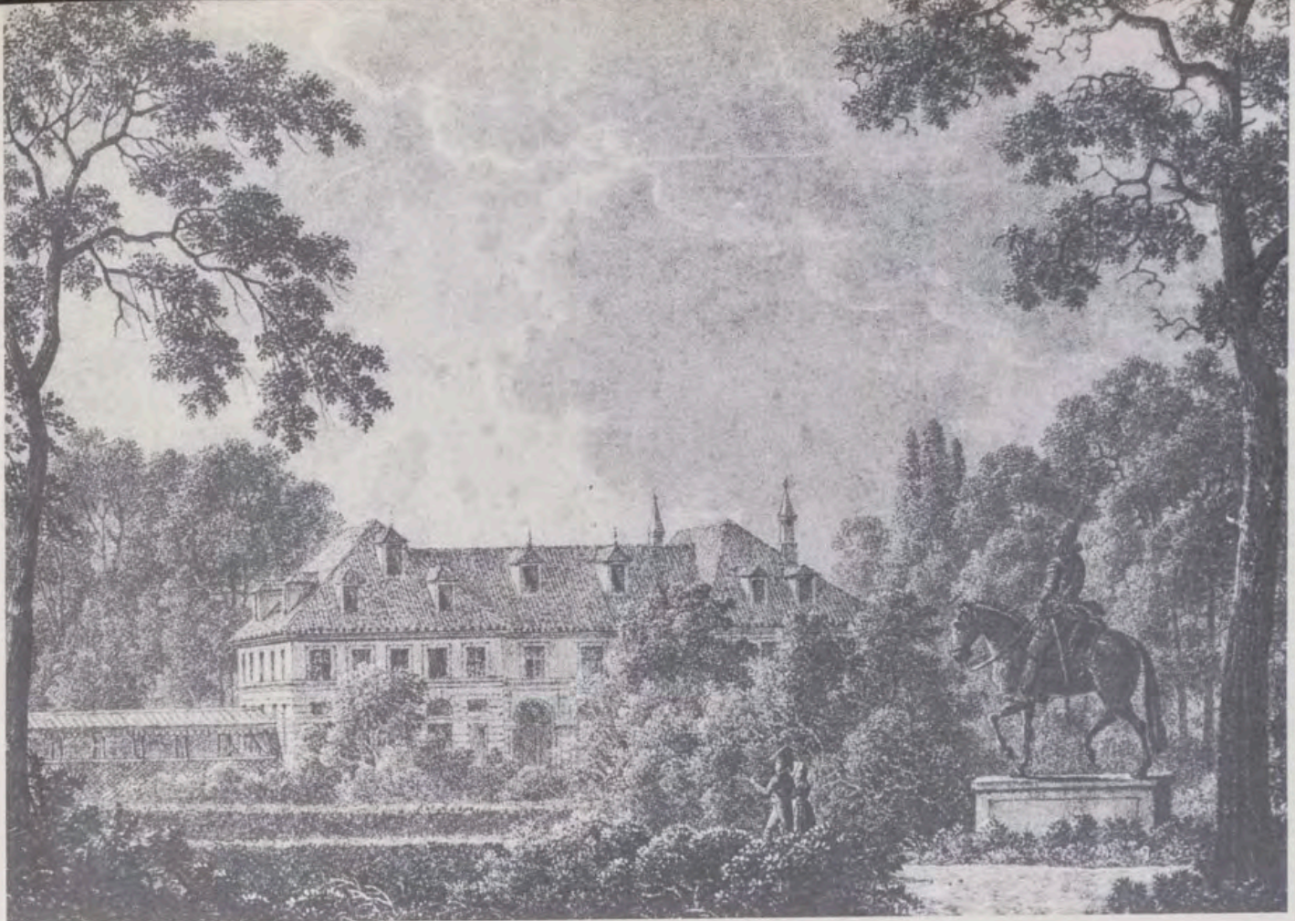
Fachada al jardín de la Casa-Palacio del Campo después de la reforma de Sabatini. Siglo XVIII.
