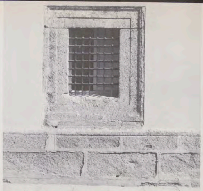
Ventana de la planta sótano que abre al foso donde estaba el jardín (1549-1550).
