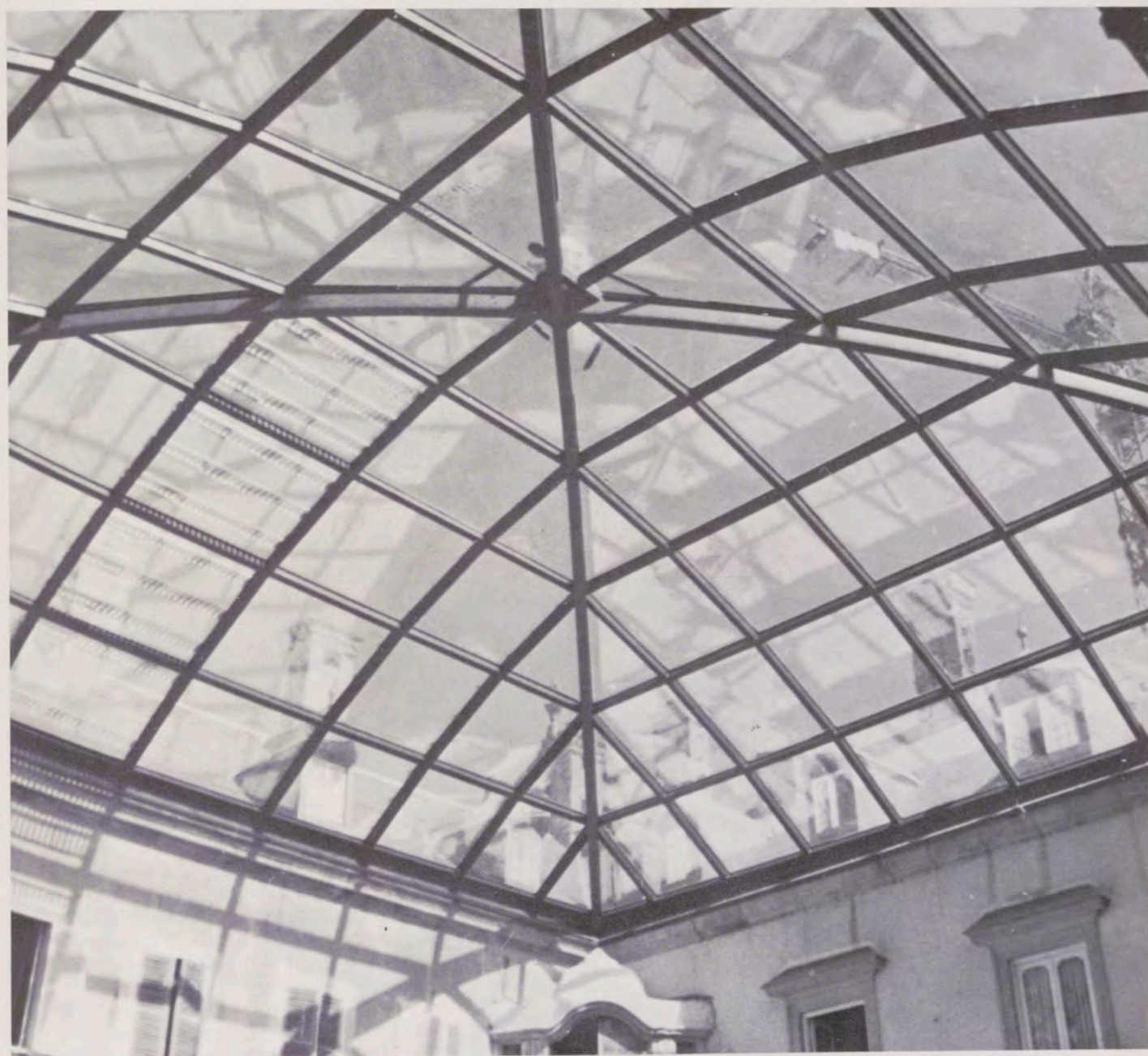
La bóveda cubre un patio rectangular con una estructura básica de dos arcos diagonales, sobre los que cargan el entramado octogonal y la cristalería.
