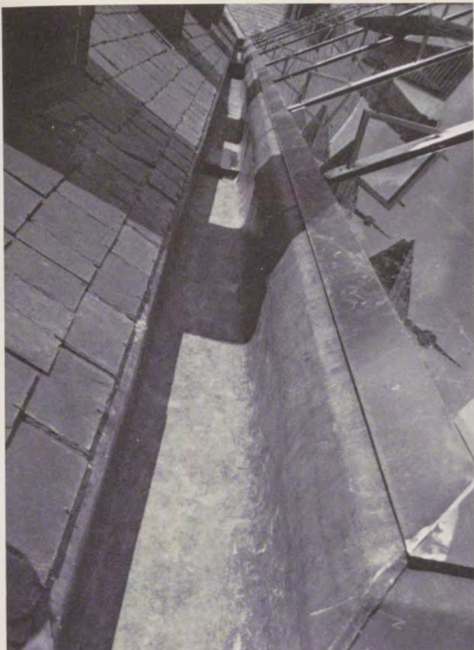
Canalón perimetral emplomado, sobre el que ataca la vertiente de pizarra de cubierta y la vertiente acristalada con marcos de acero inoxidable.
