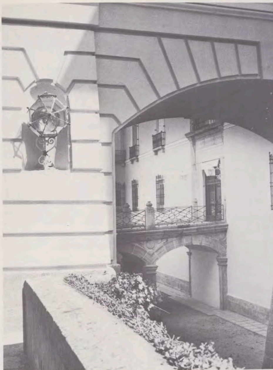
Puente que cruza el foso y conduce a la entrada principal del Palacio, terminado antes de 1556.
