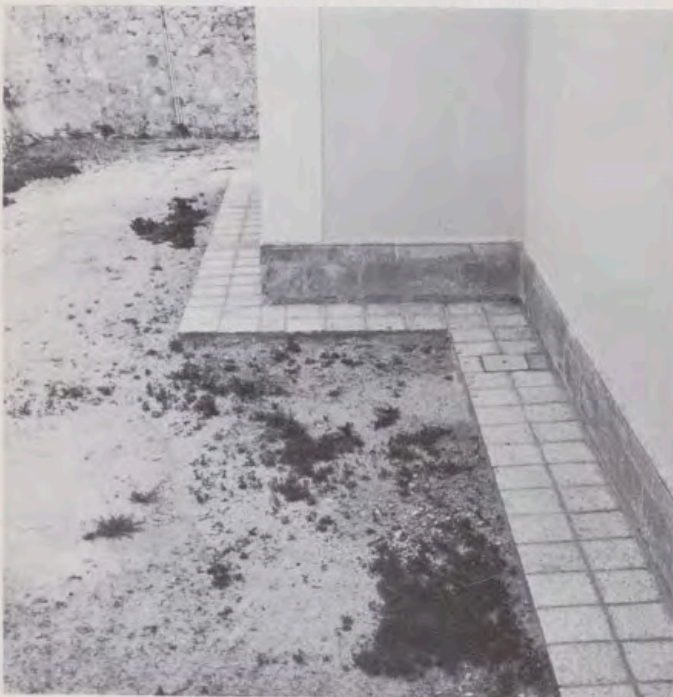
Zócalo de sillería con una pequeña moldura en la última hilera.
