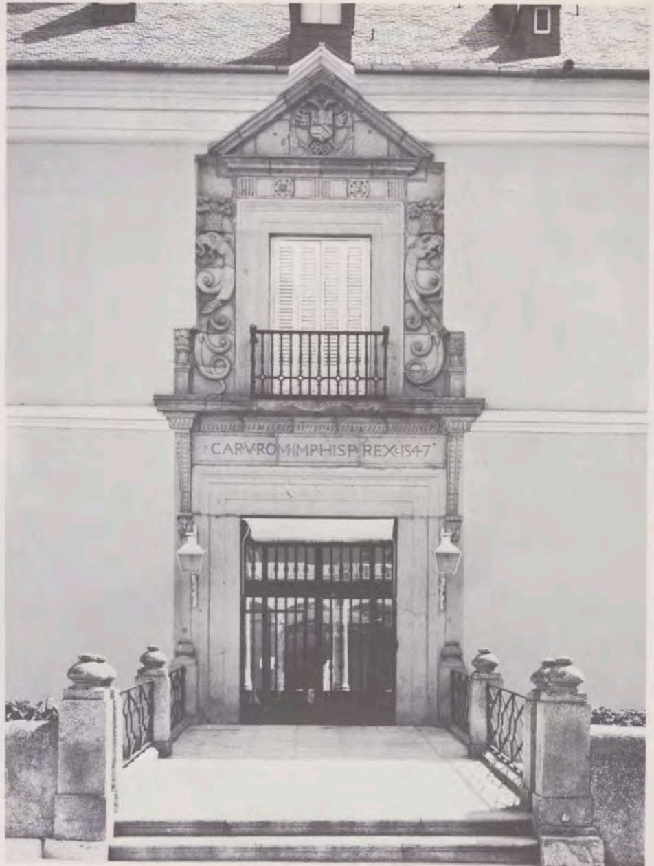
Portada del Palacio del siglo XVI (lienzo oeste), fechada entre 1546 y 1550.
