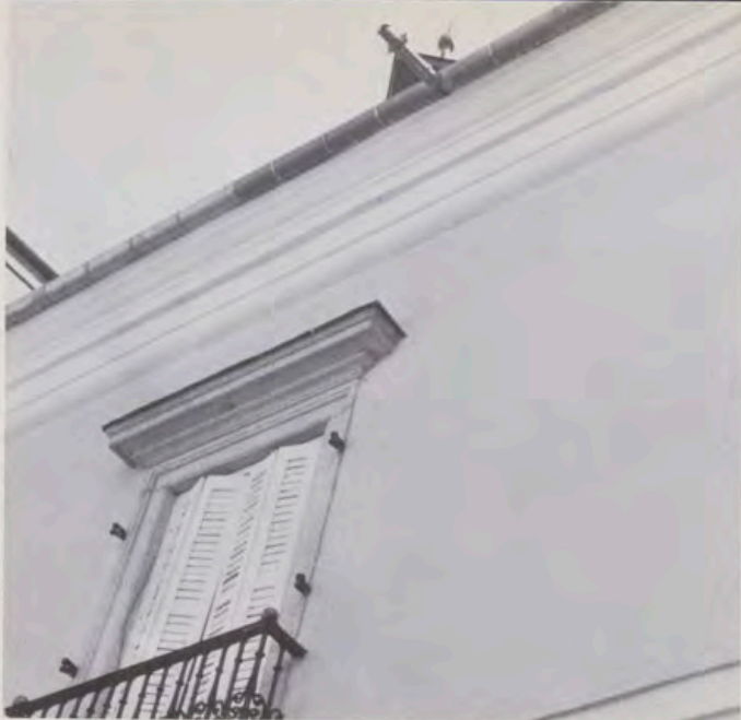
Moldura superior del muro formada por ladrillos de distinto molde.
