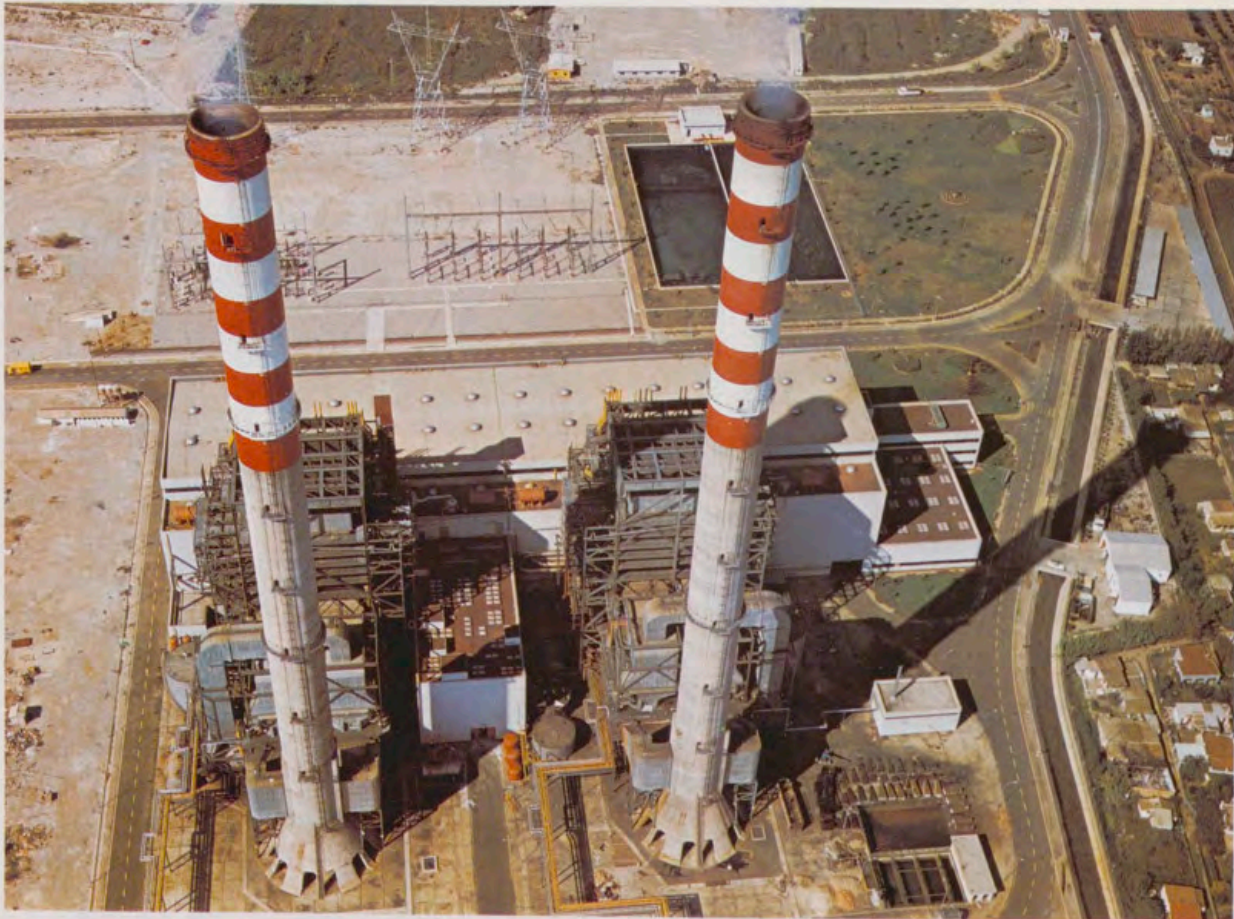
CENTRAL TÉRMICA DE CASTELLÓN
