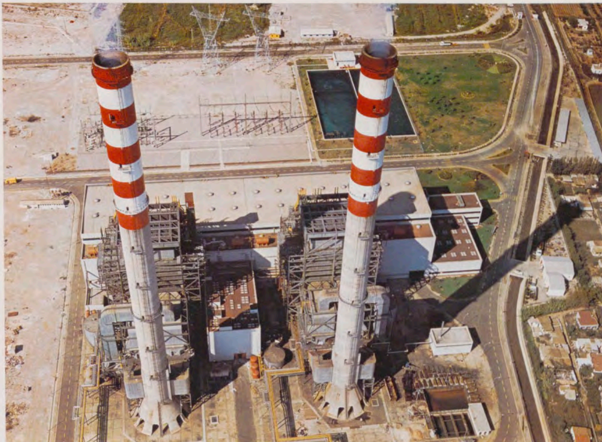
CENTRAL TÉRMICA DE CASTELLÓN
