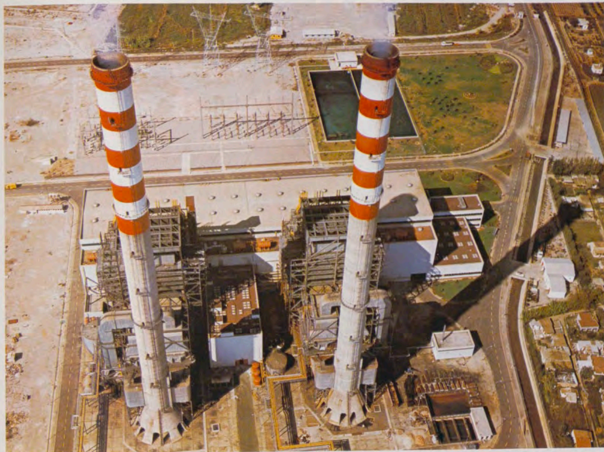
CENTRAL TÉRMICA DE CASTELLÓN
