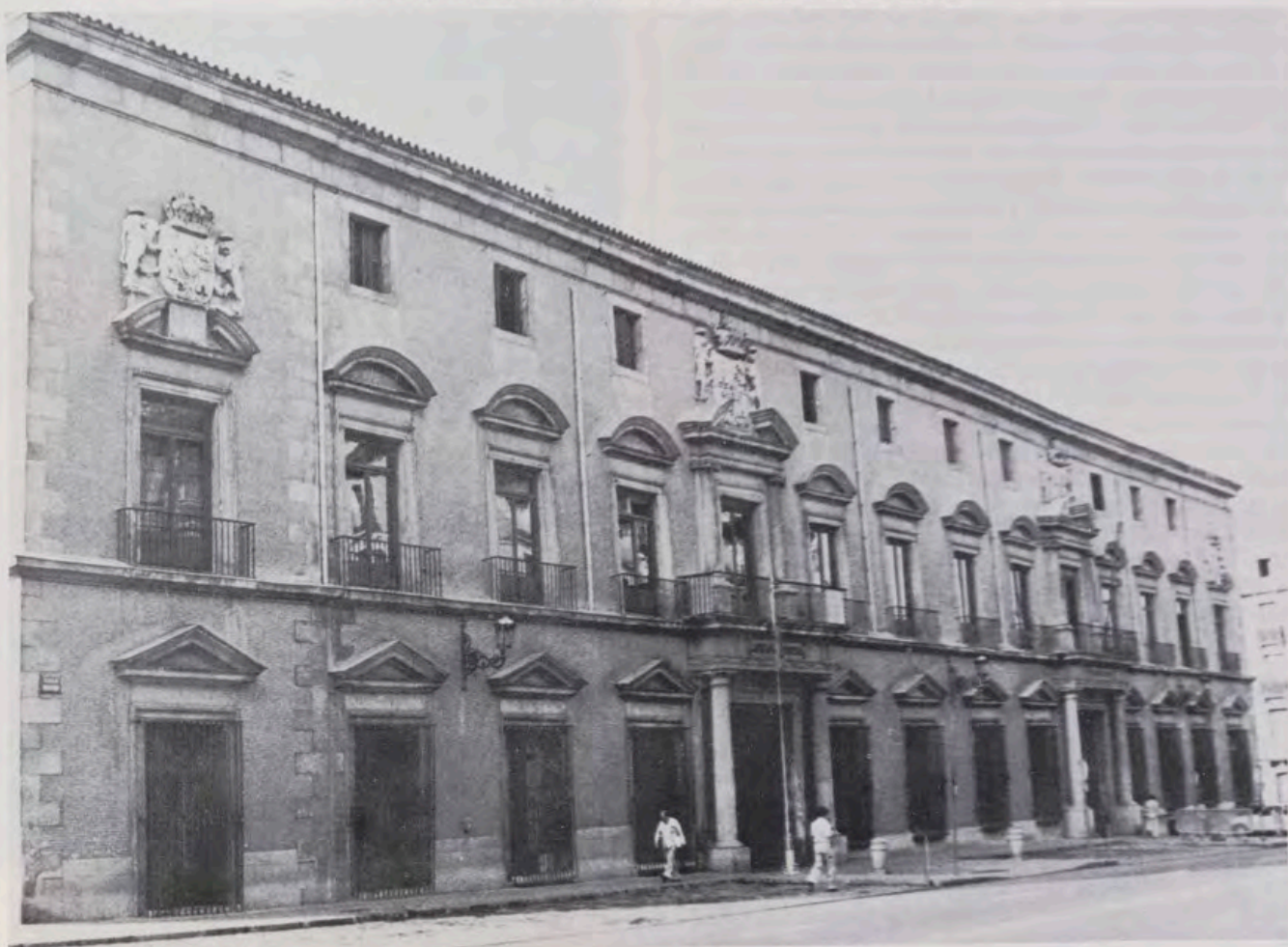
Fachada principal del Palacio de Uceda, orientada a la calle Mayor.
