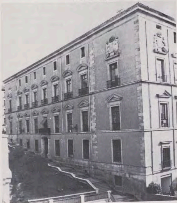
Fachada Este del edificio en la que se advierte el acentuado desnivel de su planta.
