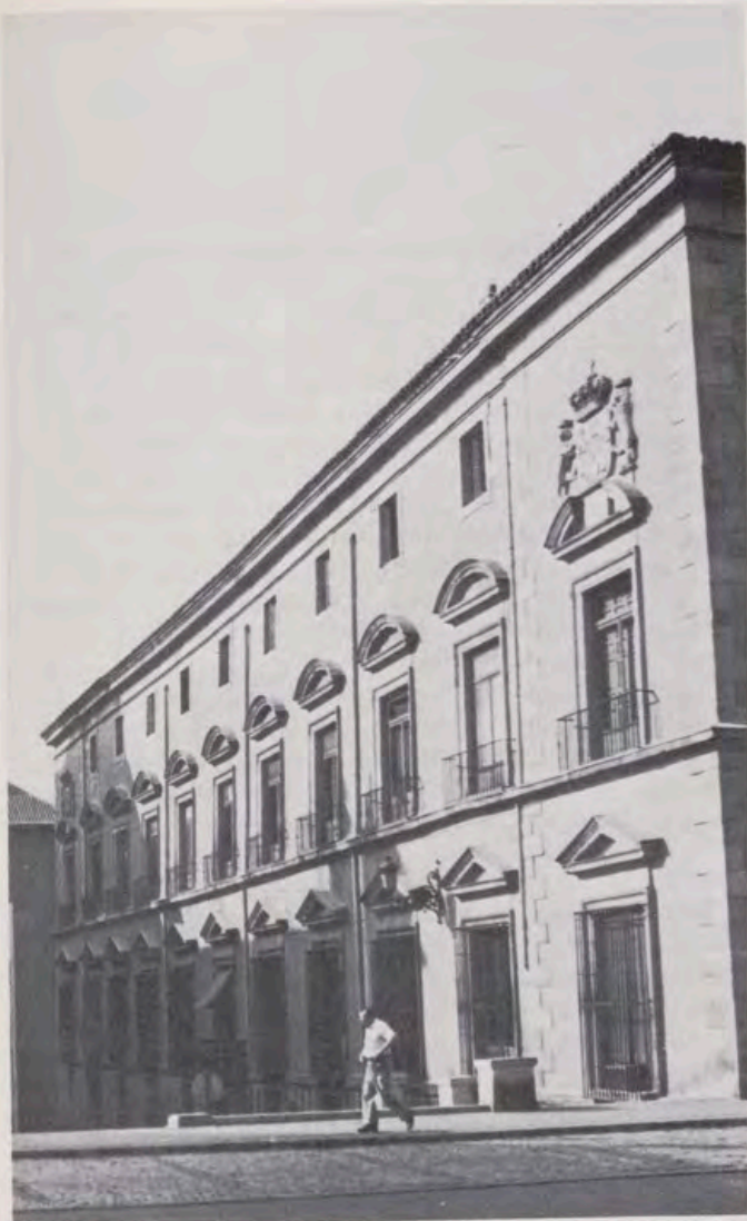
Fachada Oeste del edificio.
