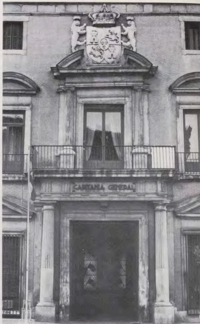
Una de las portadas de la fachada principal.
