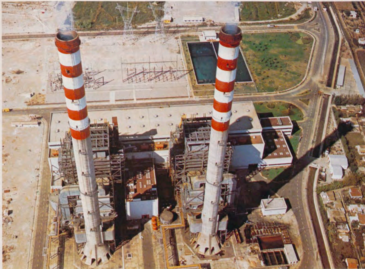
CENTRAL TÉRMICA DE CASTELLÓN
