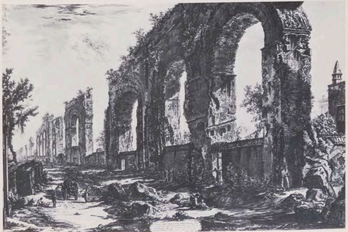
Restos del acueducto de Nerón, en «Vedute di Roma».
