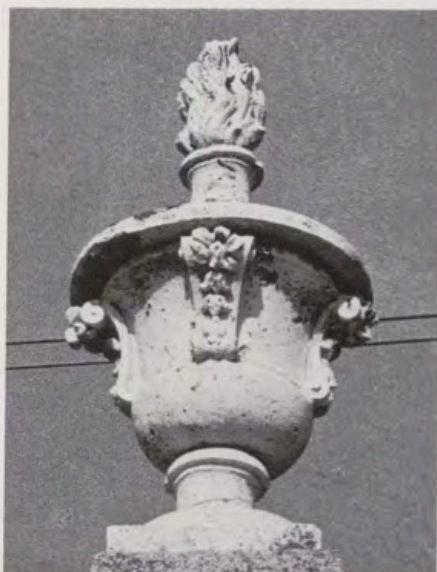
Remate de los contrafuertes: jarrón con penacho flamígero.
