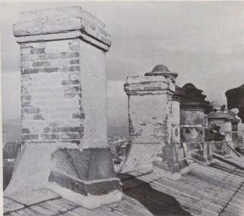
1. Vista de las chimeneas de ladrillo junto a las originales de piedra, del Palacio Real de Madrid.
