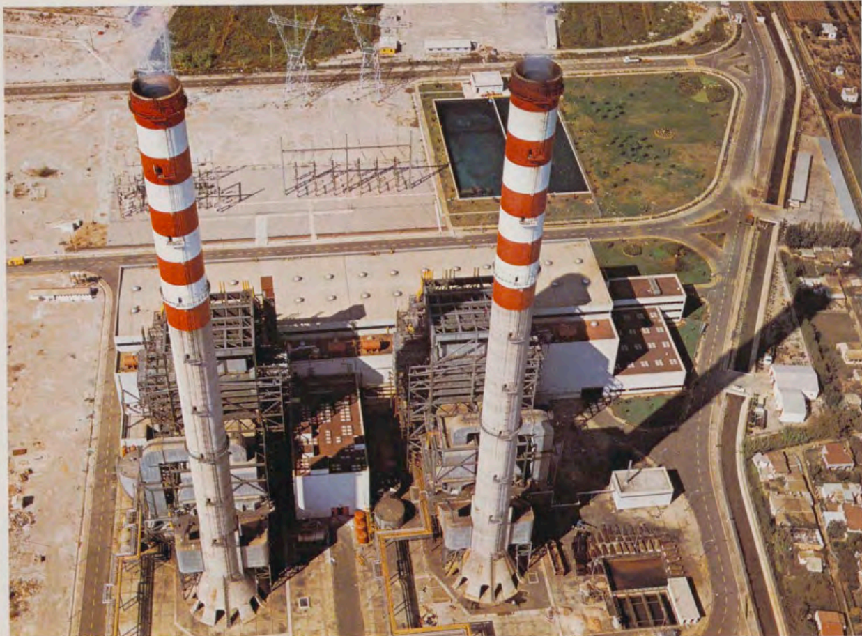
CENTRAL TÉRMICA DE CASTELLÓN
