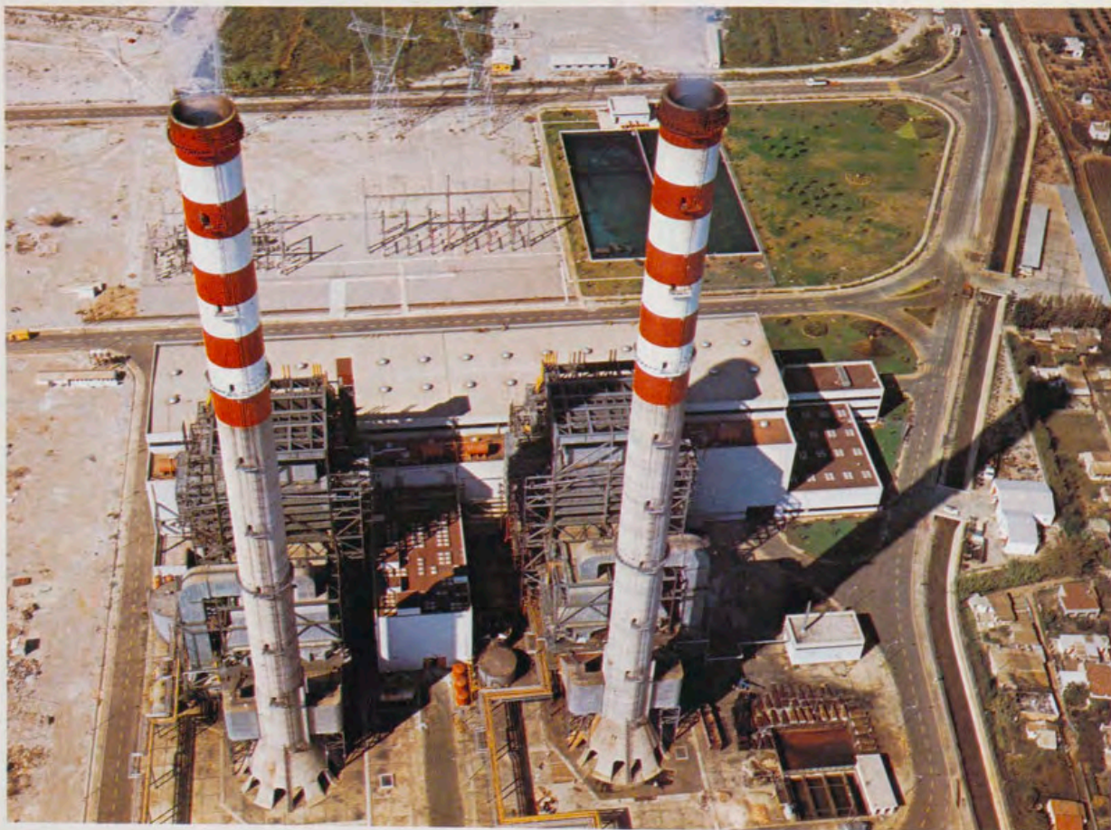
CENTRAL TÉRMICA DE CASTELLÓN
