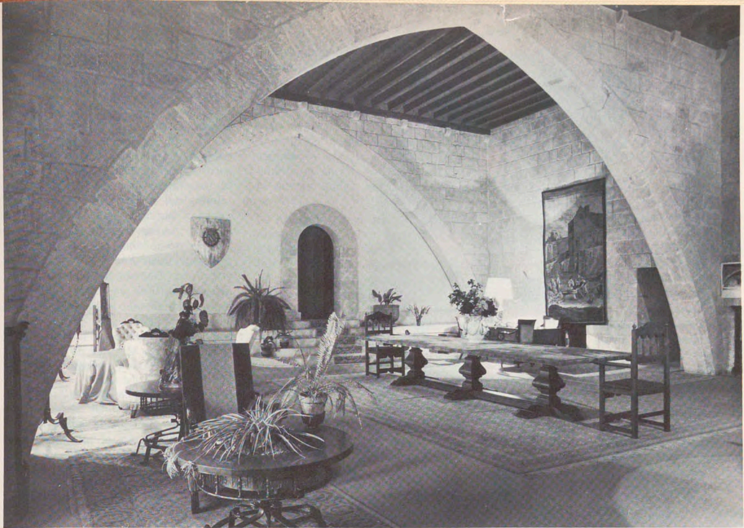
Arcos de la Sala Mayor seccionados por la interposición de una entreplanta al convertirla en Real Audiencia.
