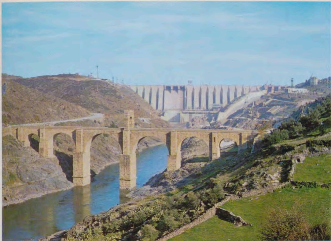
CENTRAL HIDRAULICA «JOSE M.º DE ORIOL Y URQUIJO» EN ALCANTARA (y puente romano sobre el río Tajo).
