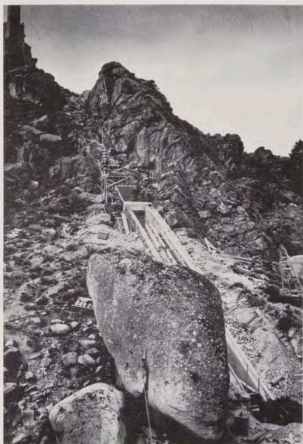
Obras de construcción de la vía respetando la entalladura natural.
