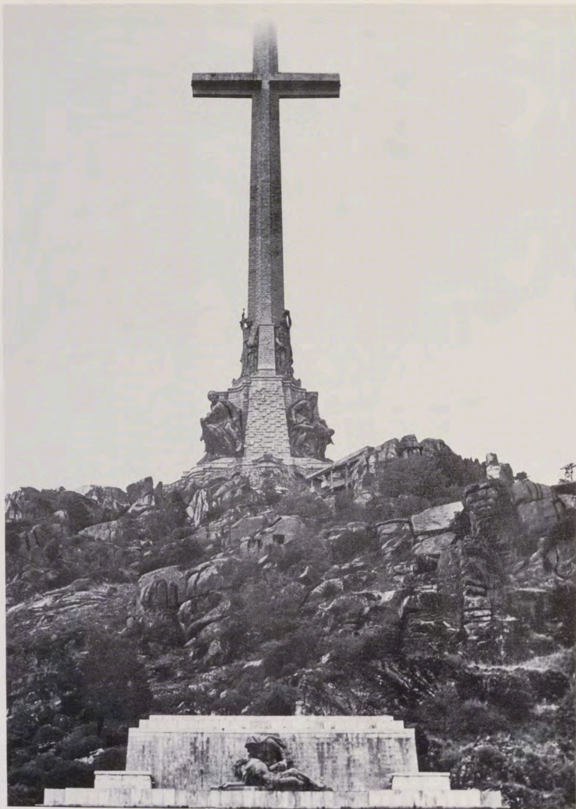
La estación superior, inmersa en el conjunto, queda adaptada en líneas y volúmenes al paisaje, y absorbida por la masa rocosa.
