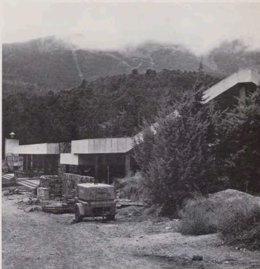
Estación de salida del funicular. El edificio se adapta al terreno.
