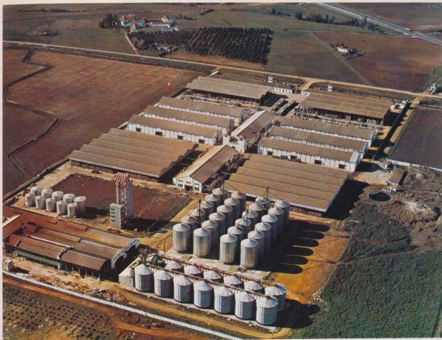
VISTA AEREA DE LA FACTORIA
