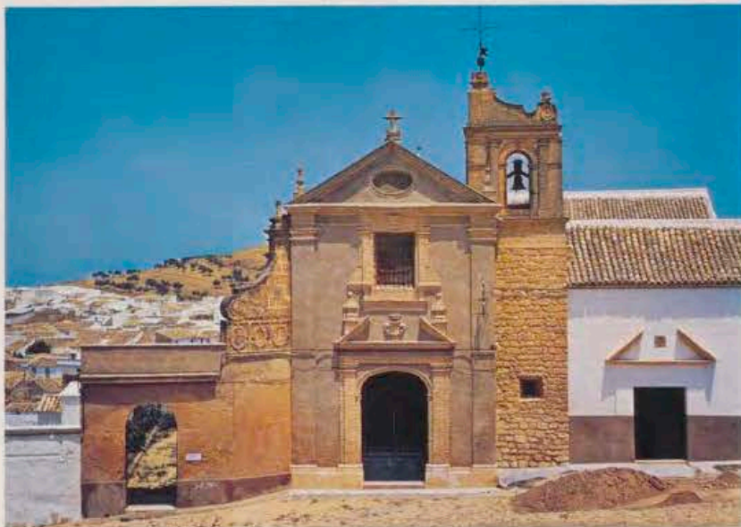
1. Fachada principal de la iglesia. Año 1626.
