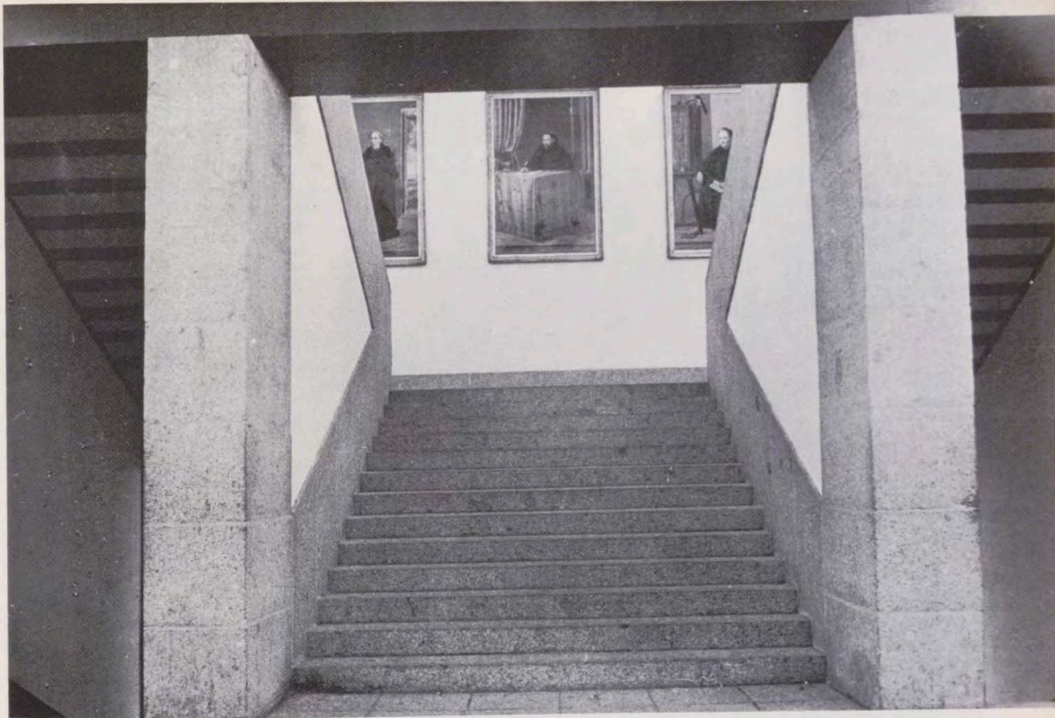
Colegio de Alfonso XII: primer tramo de la nueva escalera.
