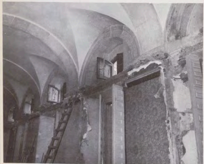
Restauración del zaguán derecho para acondicionar como cafetería: 1 y 2, interior (con la bóveda ya restaurada) donde se ven los forjados y los tabiques demolidos antes de su restauración; 3 y 4, bóveda y paramentos restaurados.
