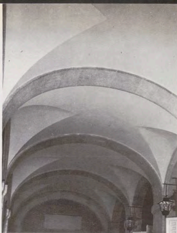
Restauración del zaguán derecho para acondicionar como cafetería: 1 y 2, interior (con la bóveda ya restaurada) donde se ven los forjados y los tabiques demolidos antes de su restauración; 3 y 4, bóveda y paramentos restaurados.
