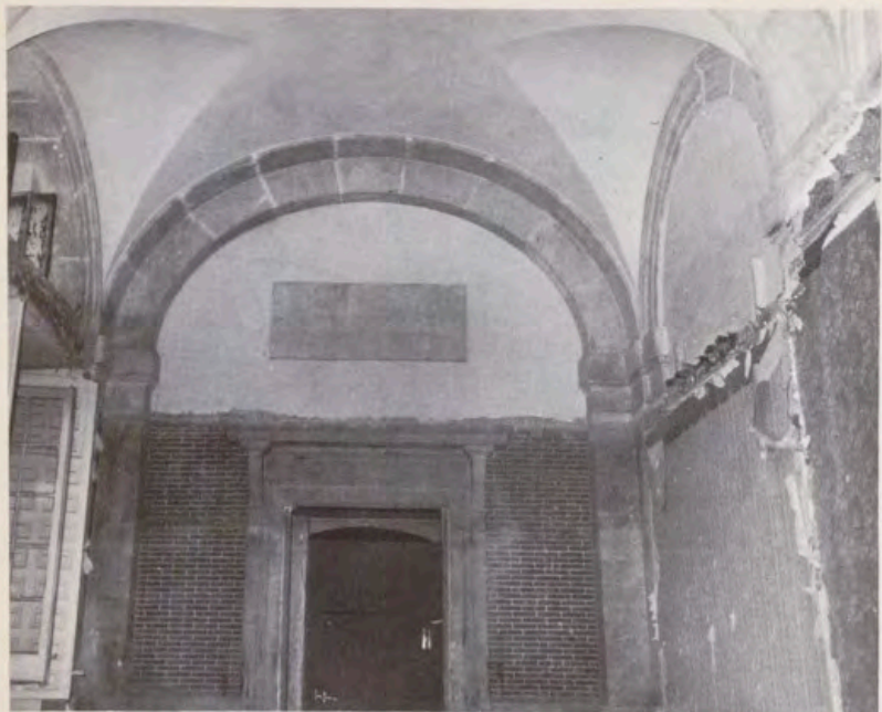
Restauración del zaguán derecho para acondicionar como cafetería: 1 y 2, interior (con la bóveda ya restaurada) donde se ven los forjados y los tabiques demolidos antes de su restauración; 3 y 4, bóveda y paramentos restaurados.
