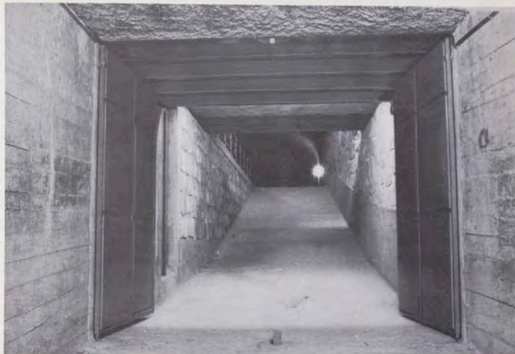
Paso en los cimientos del Monasterio junto al lugar de la primera piedra.
