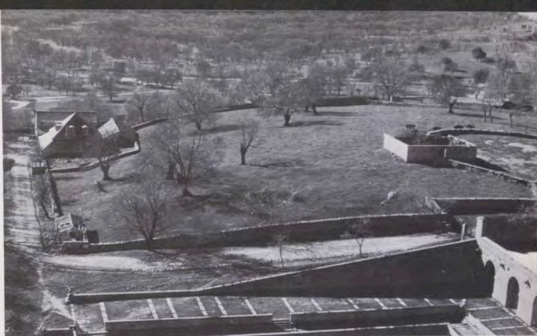
El Pozo de la Nieve (a la derecha) antes de las obras.
