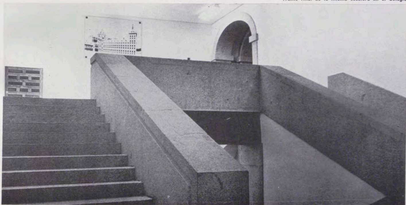
Tramo final de la misma escalera en el Colegio.
