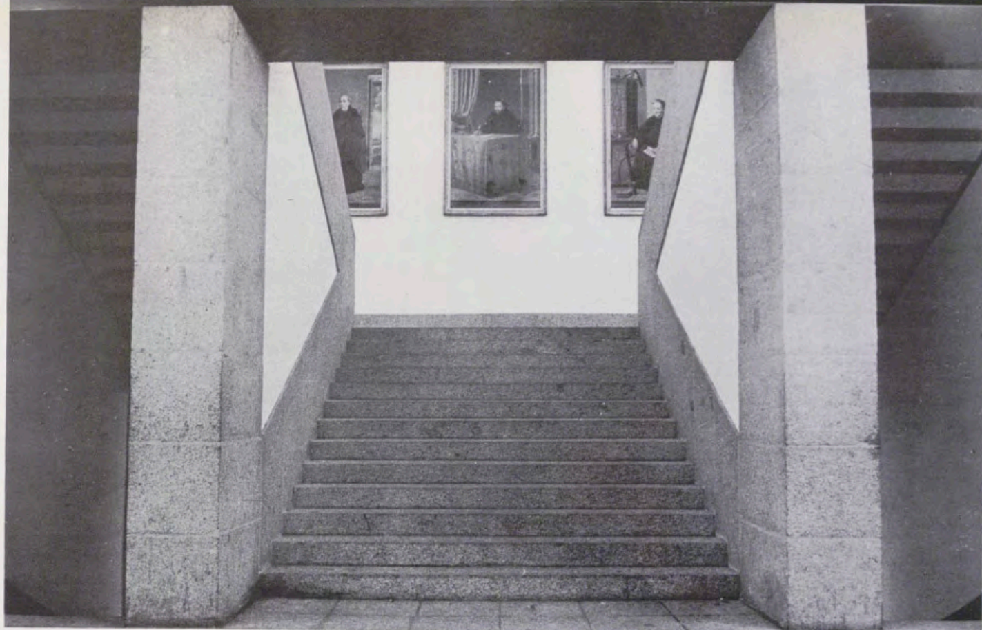
Primer tramo de la nueva escalera del Colegio de Alfonso XII.
