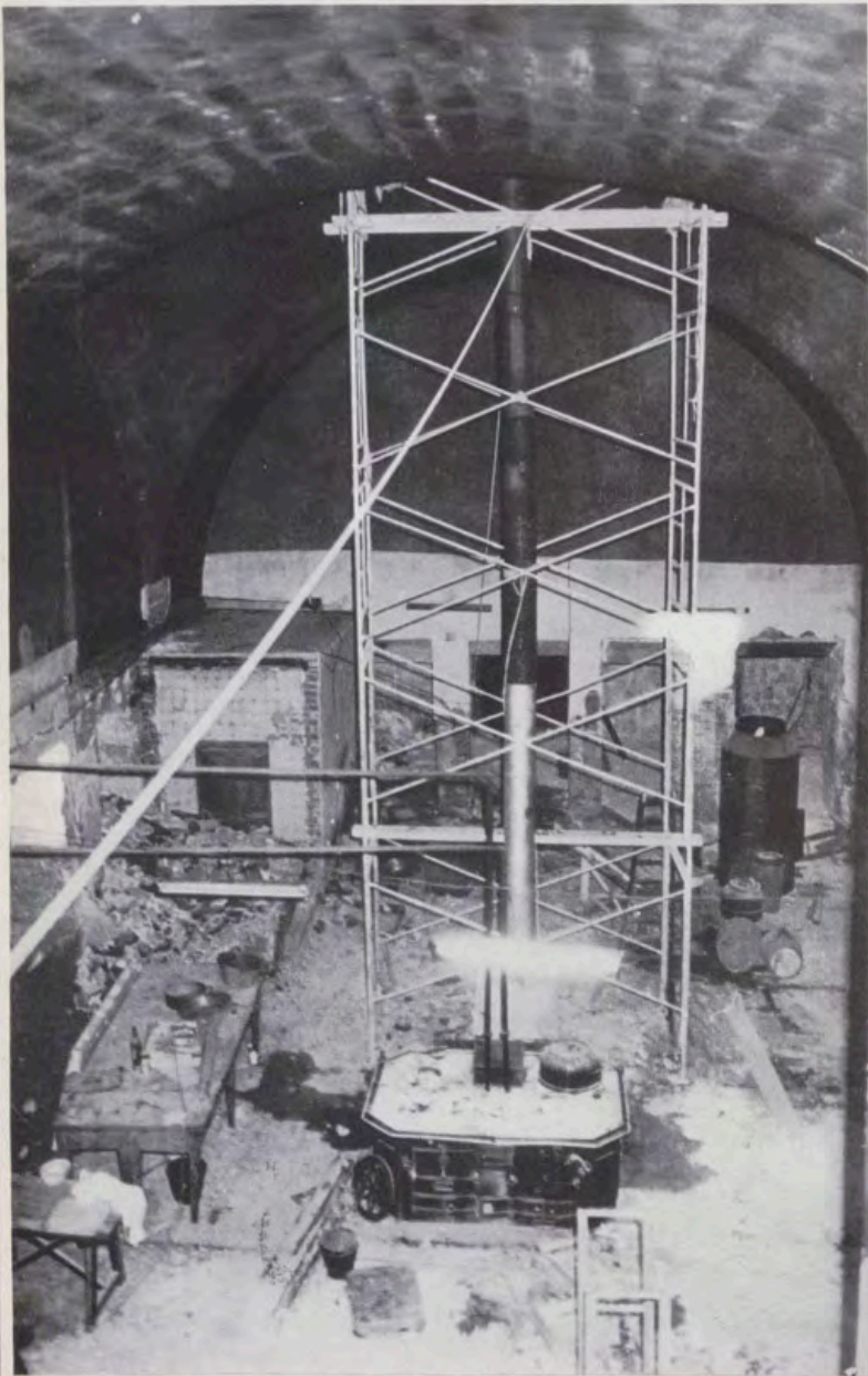
Aspecto de las antiguas cocinas del convento durante los trabajos de desmantelamiento.
