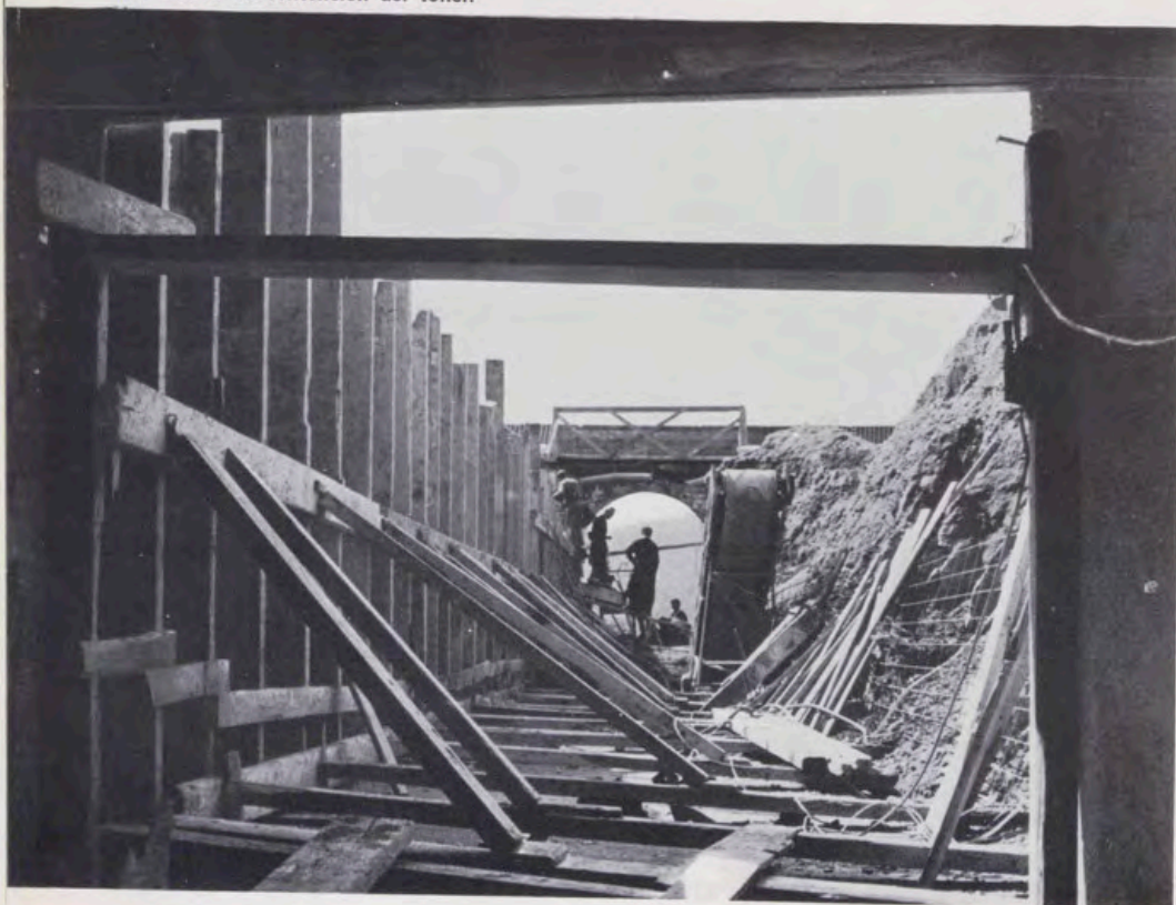
Trabajos para levantar los muros de contención del túnel.
