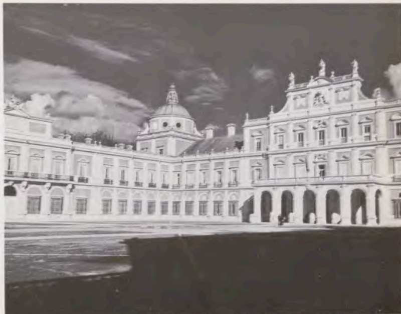
El Palacio de Aranjuez después de terminada la limpieza de las fachadas principales, que cierran por tres lados la plaza de Armas.
