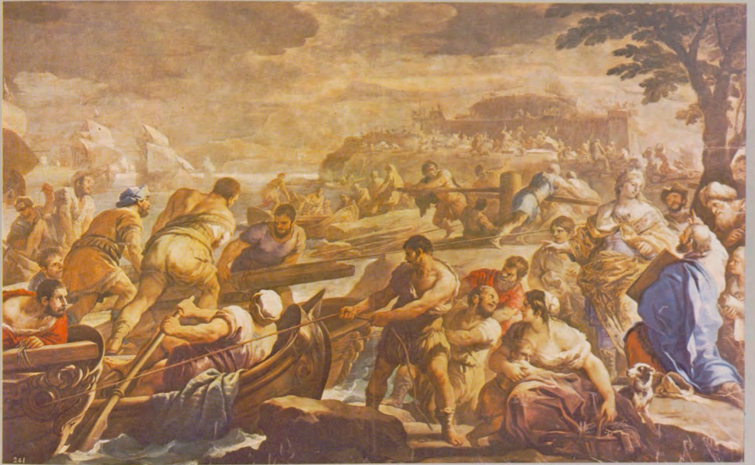
La construcción del Templo de Salomón. (Palacio de Aranjuez.)
