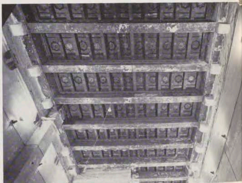
Artesonado descubierto, en uno de los palacios recientemente restaurados en la calle de Montcada.
