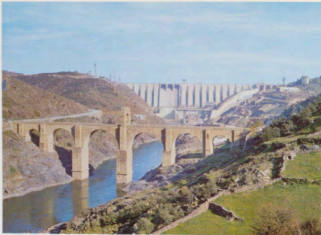
Central Hidráulica de Alcántara (y puente romano sobre el río Tajo).
